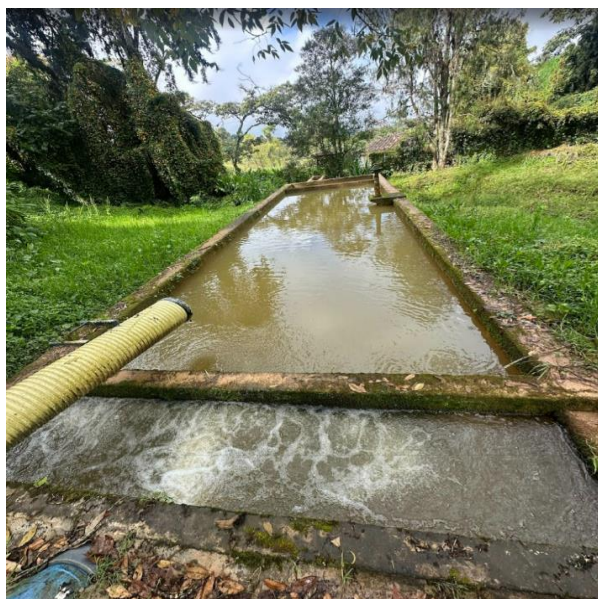
Vista superior desarenador
