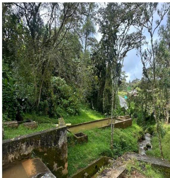
Desarenador contiguo a bocatoma
