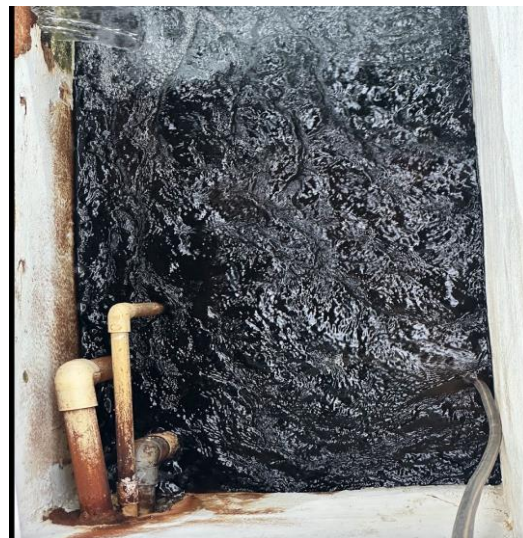
Dosificación Cloro gaseoso en canal de agua filtrada
