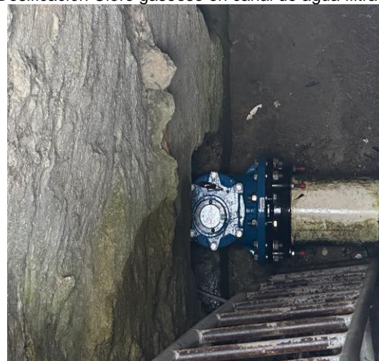
Macromedidor salida
