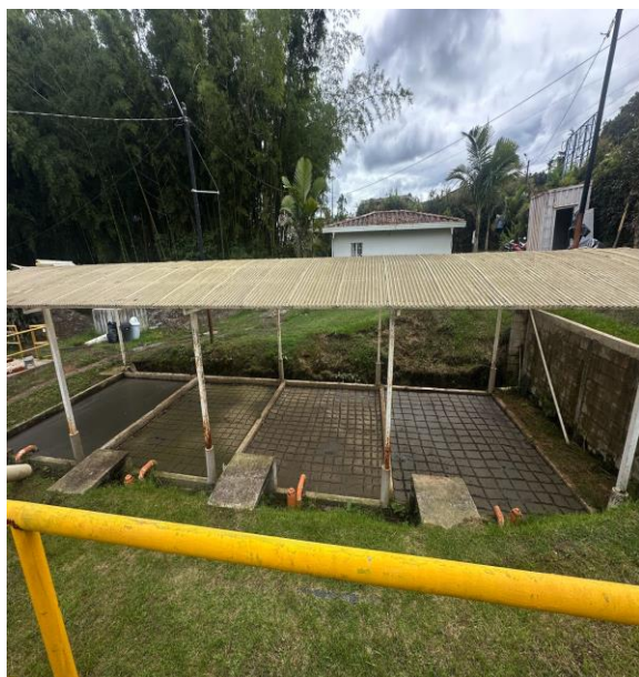
Lechos de secado lodos
