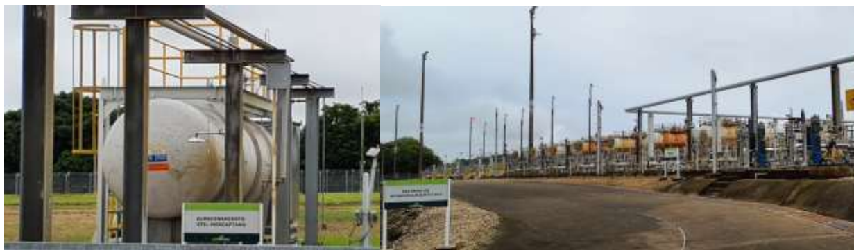
Figura 8 Sistema de almacenamiento y odorización del GLP en ECOPETROL S.A.
