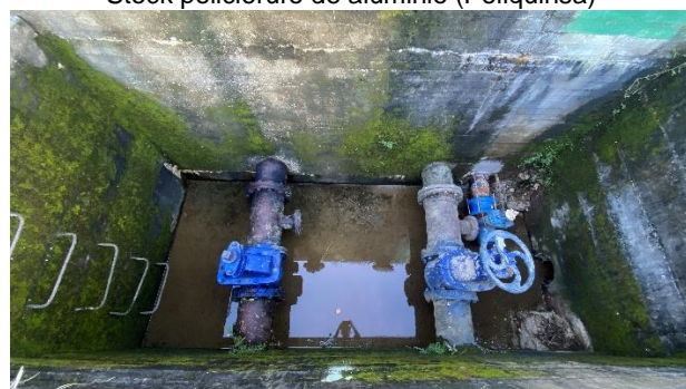
Tanque secundario de compensación y balance de caudales
