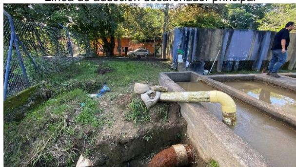
Línea de aducción desarenador secundario
