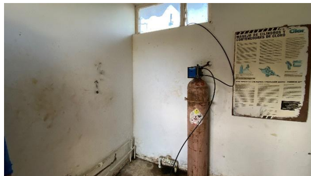
Dosificación cloro gaseoso
