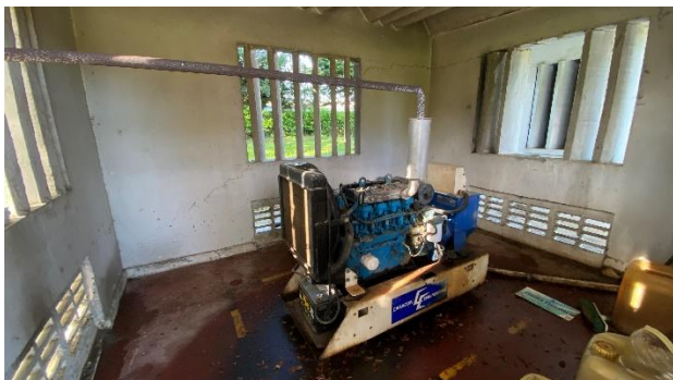
Respaldo eléctrico de energía PTAP
