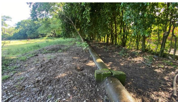
Línea de aducción desarenador principal
