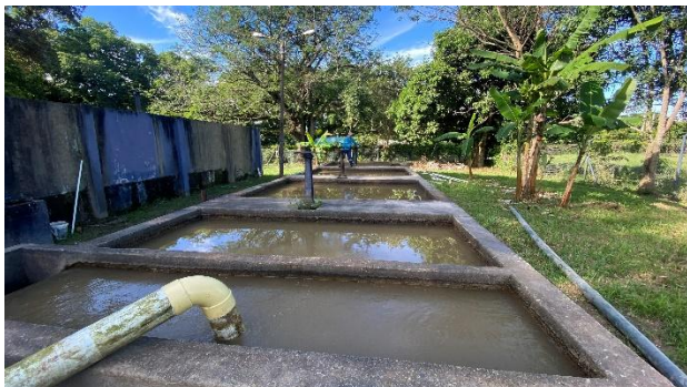
Desarenador de respaldo
