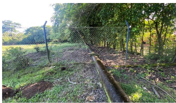
Línea de aducción desarenador principal
