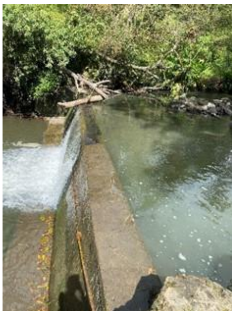
Dique transversal con rejilla horizontal
