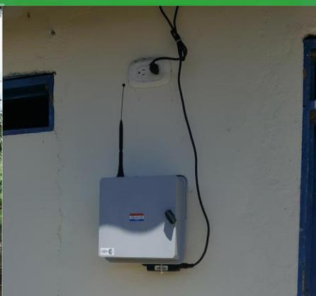
**Instalación de la macro medición por telemetría, para establecer el índice de pérdidas de agua.**
