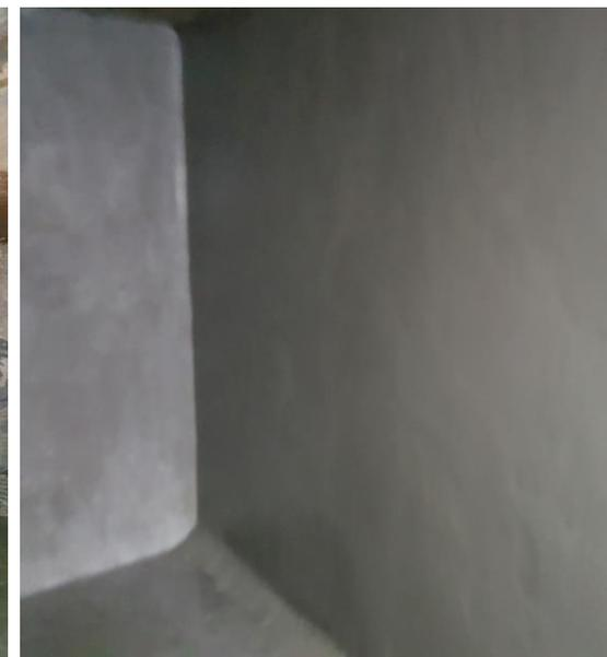
**Impermeabilización del tanque de lavado de filtros.**
