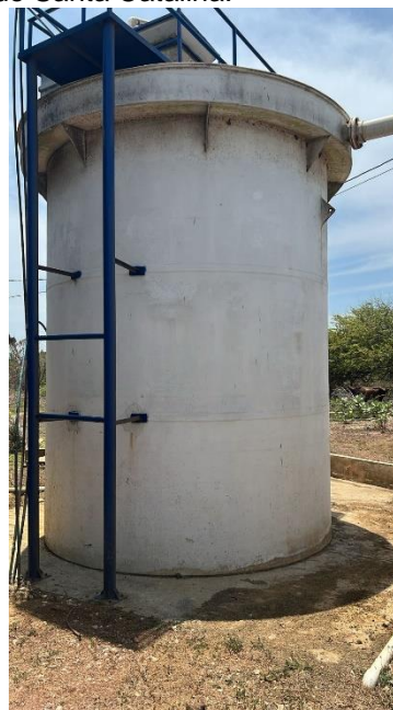
Floculación – Sedimentación
