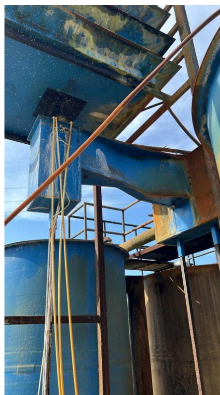
Canaleta Parshall (Coagulación)
