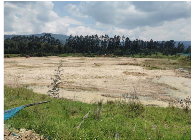
Avance de obra Optimización PTAR
