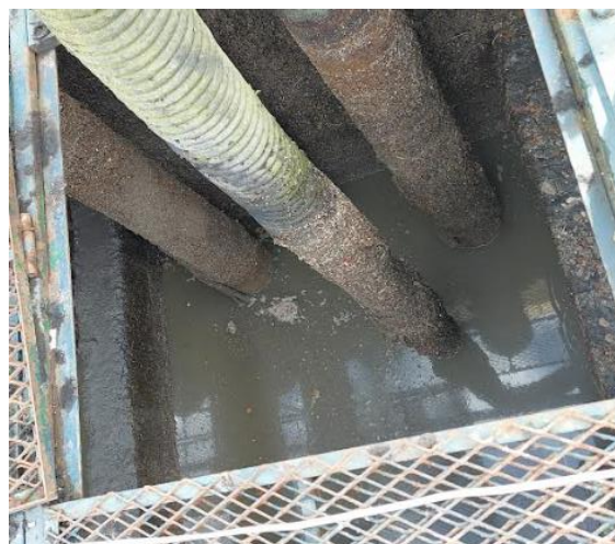
Pozo succión bombeo
