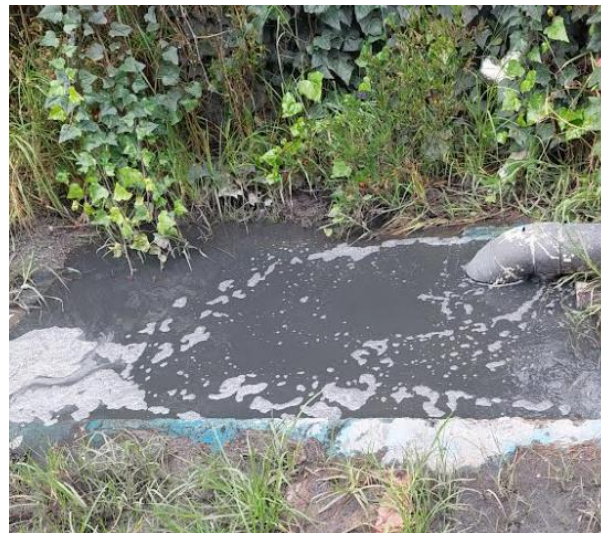
Tanque de salida
