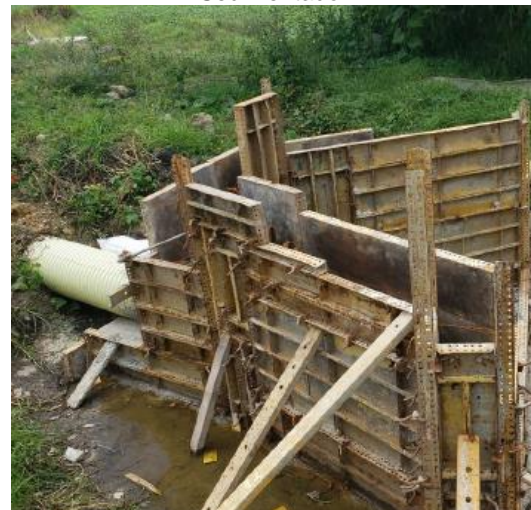
Nueva estructura de descarga
