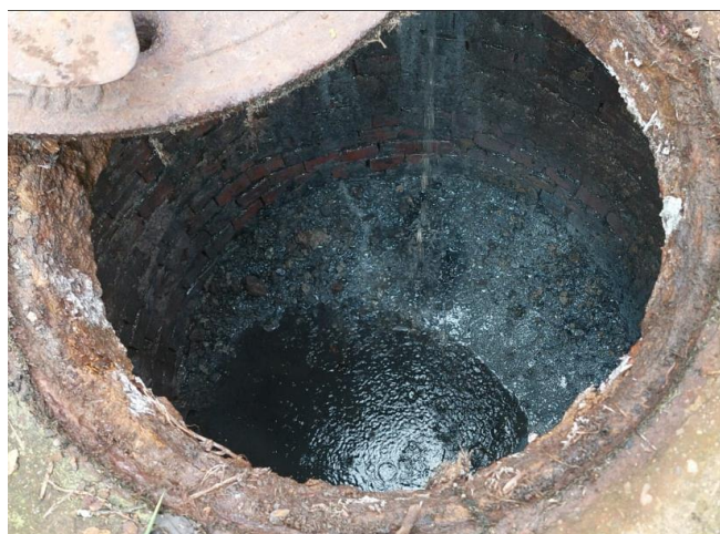
Imagen 2. Pozo séptico vereda Mercenario
