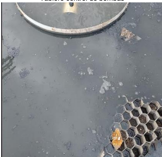
Colmenas sedimentador
