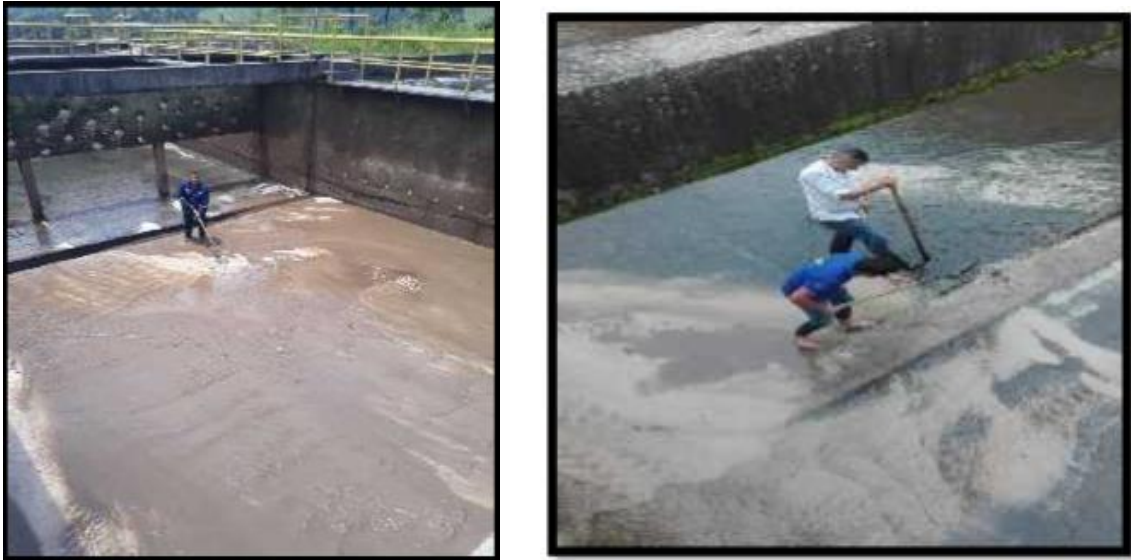
Imagen 8. Mantenimiento Desarenador
