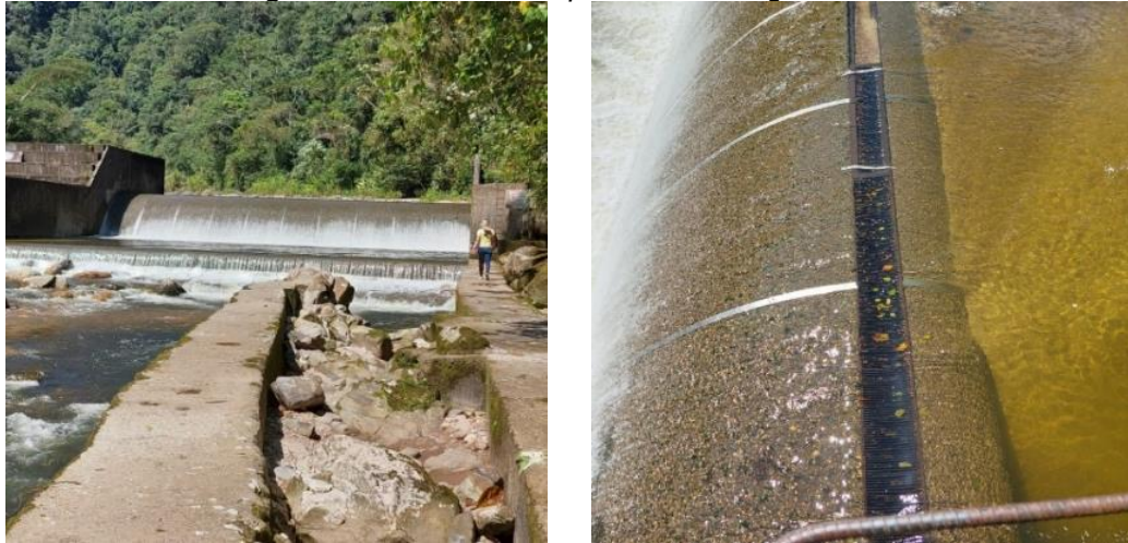
Imagen 4. Estructura de captación Caño Aguas Claras
