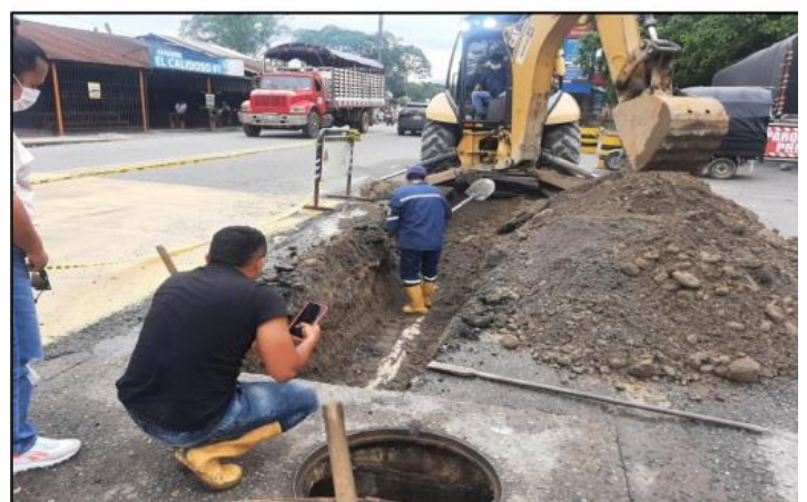
Arreglo fuga red de conducción
