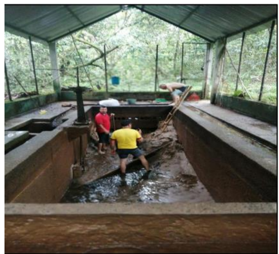
Imagen 9. Mantenimiento Desarenador
