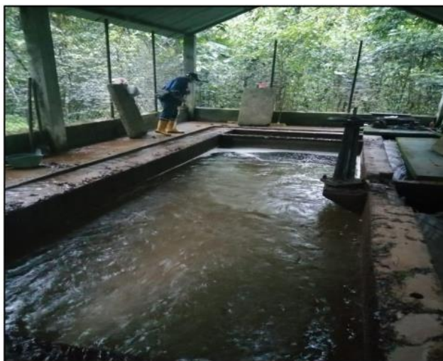
Imagen 9. Mantenimiento Desarenador
