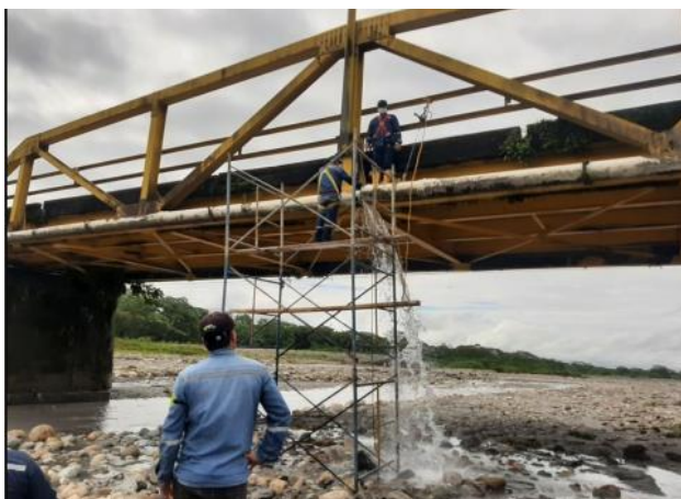
Arreglo fuga red de conducción
