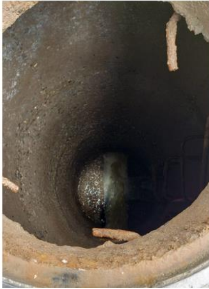
Cámara de inspección alcantarillado sanitario
