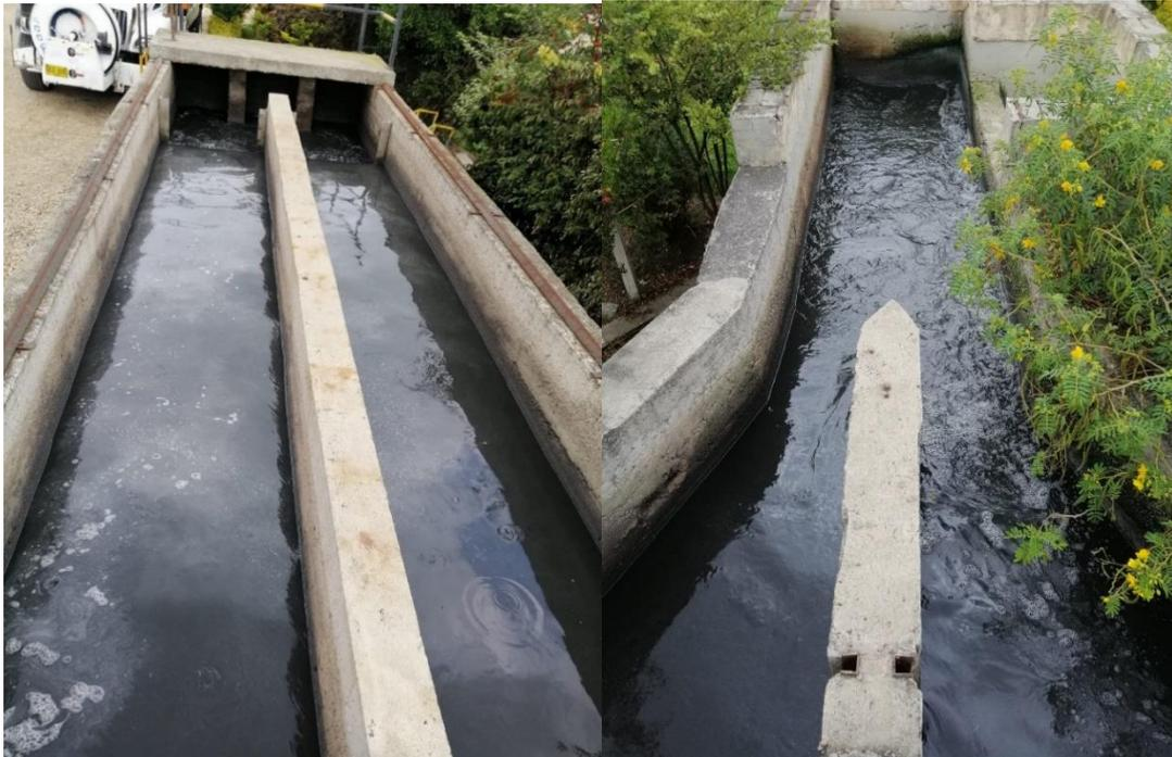
La planta cuenta con un desarenador gravitacional tipo decantación simple, conformado por dos canales rectangulares, con capacidad hidráulica de 120 lps. Su función es decantar arena mínimo de 0.3mm de diámetro, por lo que permite la sedimentación de materia orgánica.
