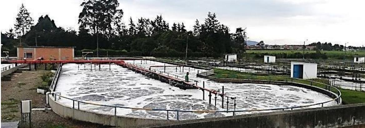
*Ilustración 12. Laguna de Oxidación*
