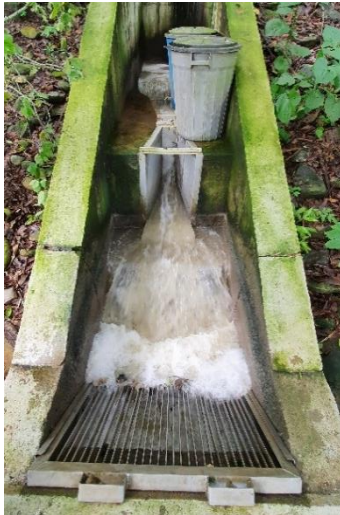
Canaleta parshall, aplicación de hidroxiclورو de aluminio y rejillas de cribado
