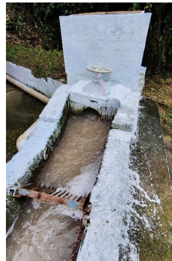
Estructura de entrada
