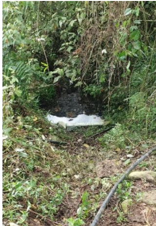
Punto de vertimiento
