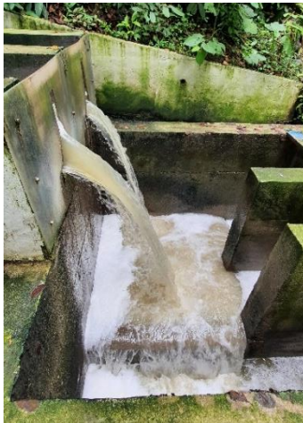
Canaleta parshall, aplicación de hidroxiclورو de aluminio y rejillas de cribado
