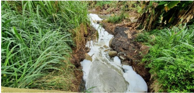
Punto de vertimiento
