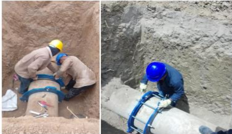
Imagen 3. Obra de Instalación de Uniones línea de Conducción
