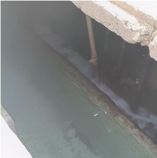
Adición de cloro
