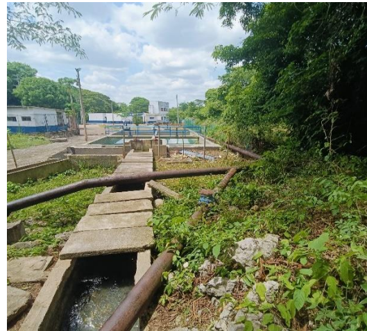
Canal de aducción
