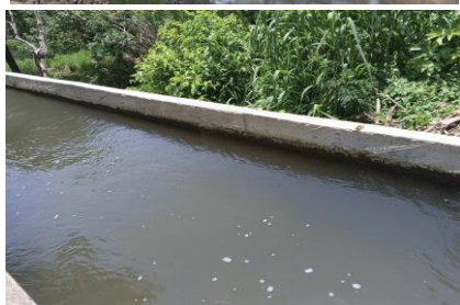
Juntas y paredes del canal elevado con revestimiento nuevo
