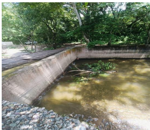
Muro de control de paso
