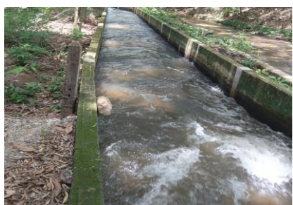
Imagen 12. Mantenimiento de canales de aducción.
