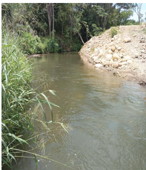
Bancas del canal de lecho natural modificadas y estabilizadas con material granular grueso
