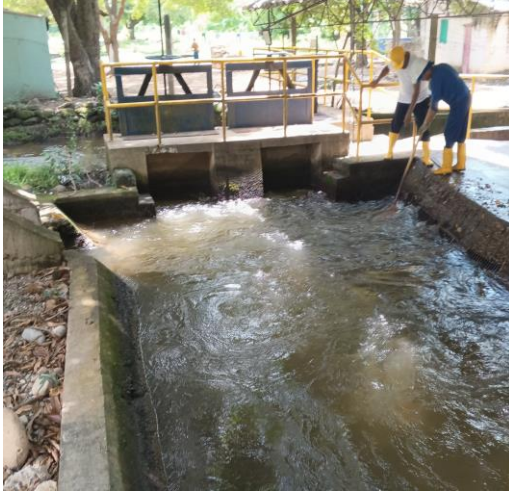
Estructura de control, canal de excesos Derivación a las PTAPs Huaricha y Gota Fría.
