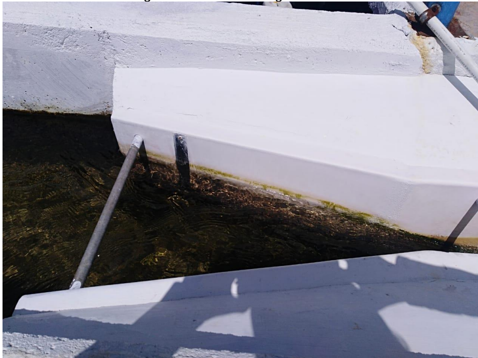
Imagen 6 Estructura de ingreso a la PTAP
