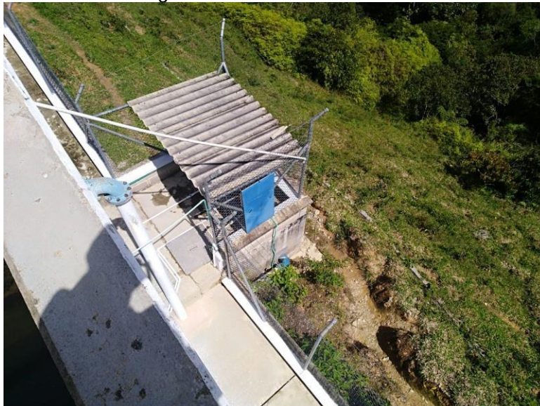
Imagen 10 Sistema de desinfección
