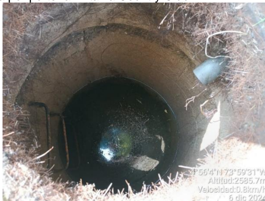
Pozo de inspección de alcantarillado no operativo.
