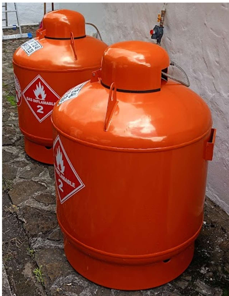
Figura 6. Tanques estacionarios de la empresa ROSCOGAS S.A. E.S.P. instalados en el domicilio del usuario.
