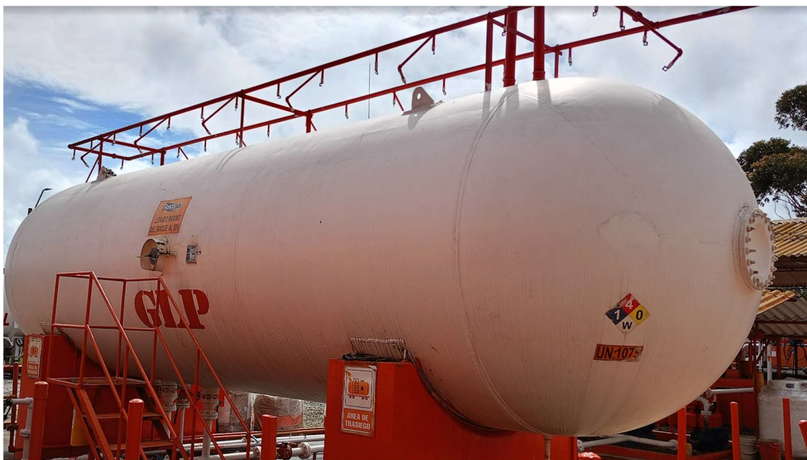
Figura 7. Tanques estacionarios de almacenamiento y drenaje de la planta de envasado de la empresa ROSCOGAS S.A. E.S.P. en La Ceja, Antioquia.
