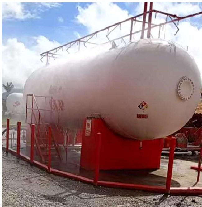
Figura 4. Prueba de la red contra incendios para el tanque de almacenamiento de GLP en la planta de envasado de ROSCOGAS S.A. E.S.P. en La Ceja, Antioquia
