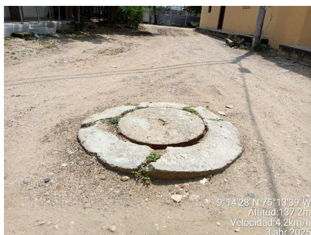
Estructura de acceso del MH de Albania fracturado
