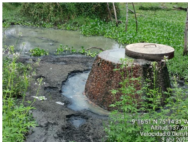
Colapso y rebosamiento de red de alcantarillado área urbana previo ingreso parcial al STAR No. 4
