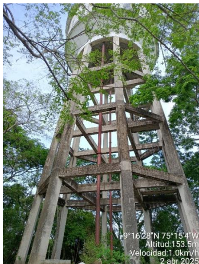
Tanque de almacenamiento elevado de agua cruda proveniente del pozo profundo No. 2, mantenimiento deficiente.
