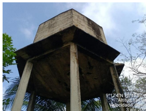
Tanque de almacenamiento elevado de agua cruda del corregimiento de Sabaneta en estado operativo. Fuente: Registro fotográfico de la visita SSPD, abril de 2025.
