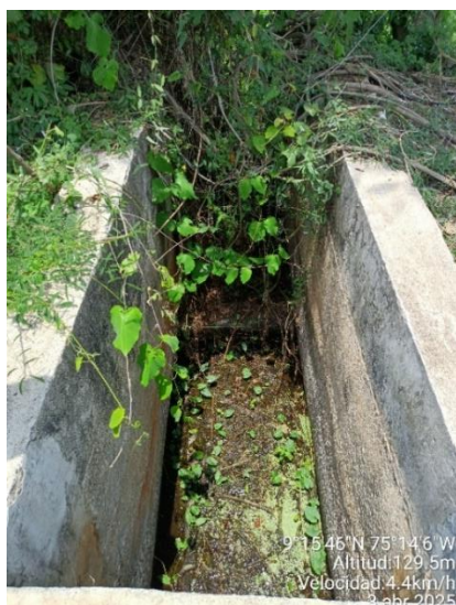
Estructuras de conexión entre lagunas no operativas.
