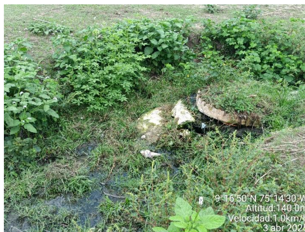
Colapso y rebosamiento de red de alcantarillado
