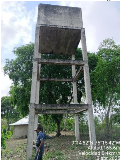
Tanque de almacenamiento elevado de agua cruda sector de Loma Alta en estado no operativo.
