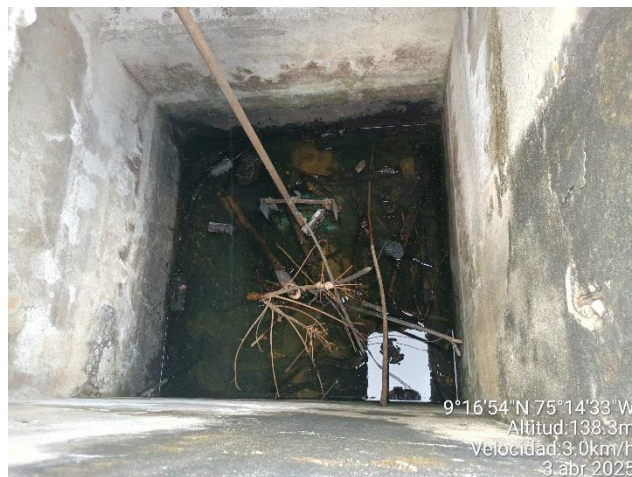
Estructuras de conexión entre lagunas no operativas.
