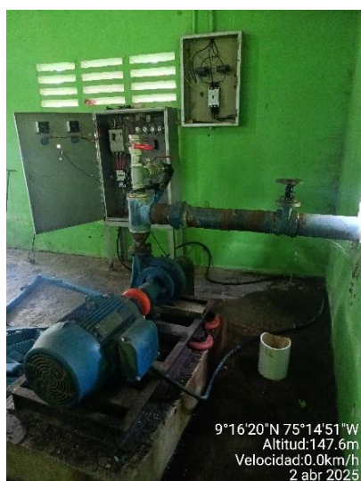
Fugas de agua en la tubería, mantenimiento deficiente e instalaciones eléctricas sin señalización.
