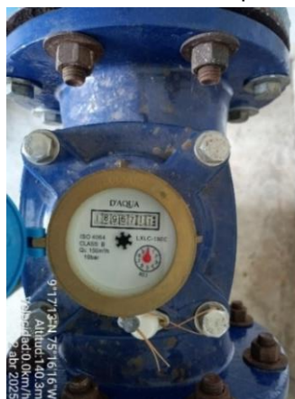
Imagen 8. Macromedidor a la salida del pozo profundo No. 2.
