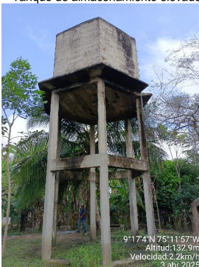
Tanque de almacenamiento elevado de agua cruda del corregimiento de Sabaneta en estado operativo. Fuente: Registro fotográfico de la visita SSPD, abril de 2025.
