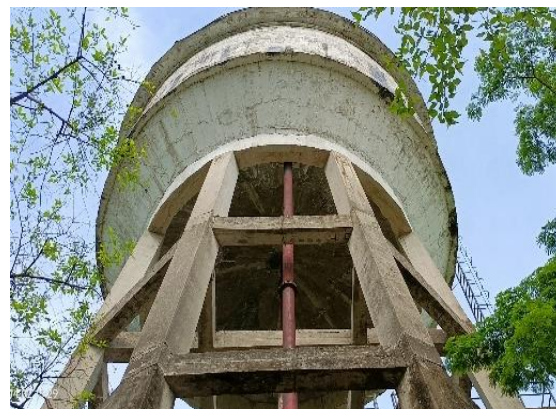
Tanque de almacenamiento elevado de agua cruda proveniente del pozo profundo No. 2, mantenimiento deficiente.
