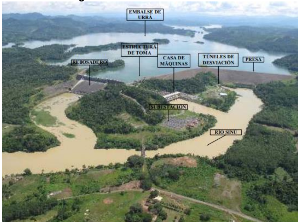
Figura 15 Central hidroeléctrica Urra I.
