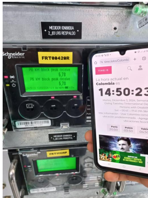
Figura 7. Verificación de la sincronización del reloj del medidor de respaldo.
