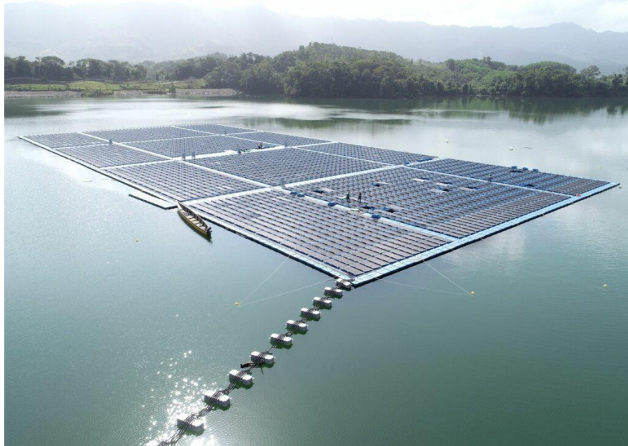
Figura 16 Proyecto AQUASOL, Central hidroeléctrica Urra I
