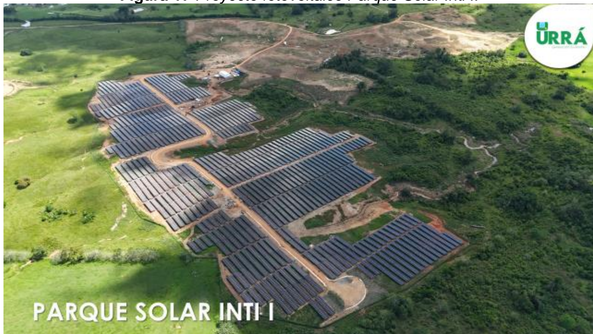
Figura 17 Proyecto fotovoltaico Parque Solar Inti I.
