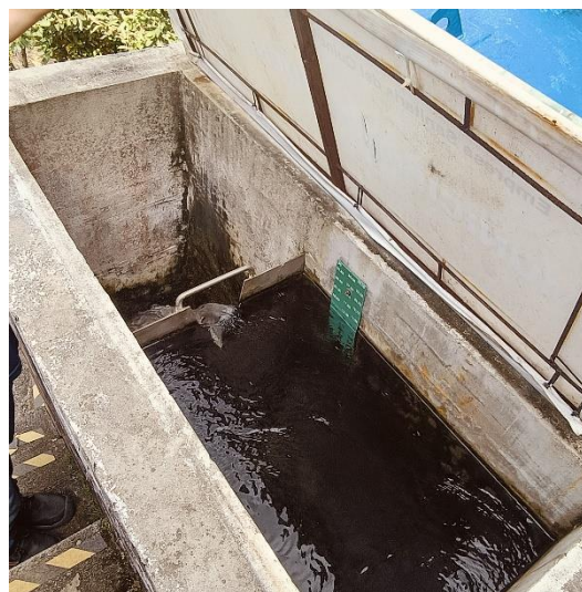
Camara de agua filtrara- medición caudal
