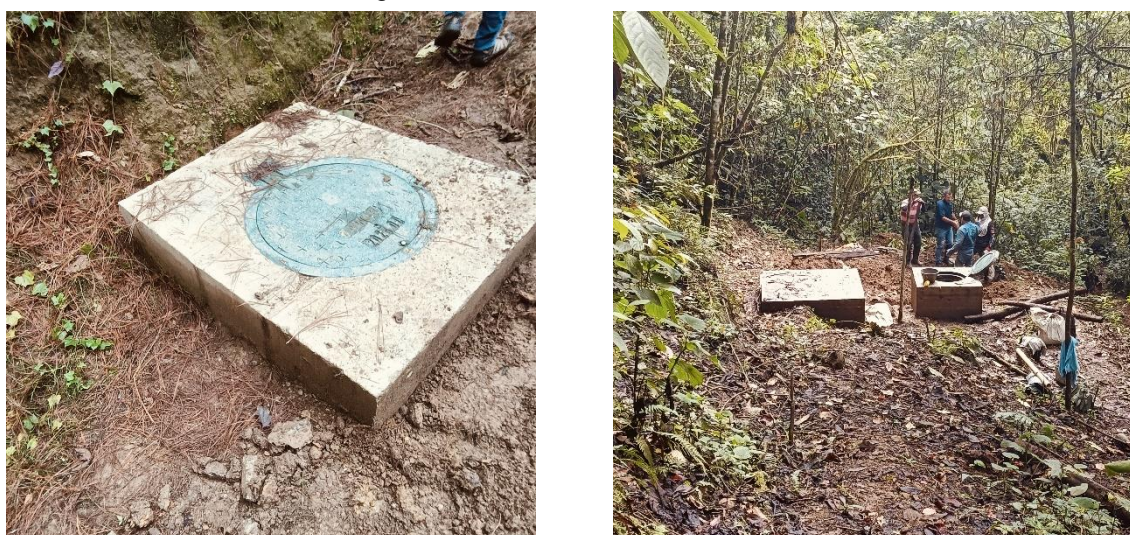
Cámaras de Quiebre en construcción
