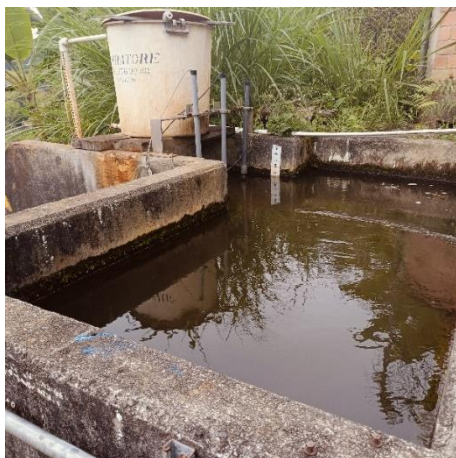
Tanque ingreso agua cruda- medición de caudal
