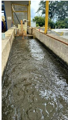
Mezcla de coagulante
