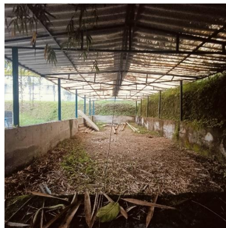
Lechos de secado - lodos
