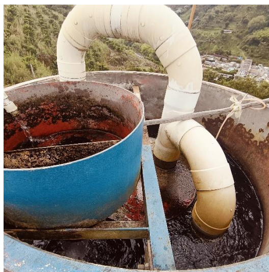
Sistema Pulsator - Punto de dosificación de coagulante
