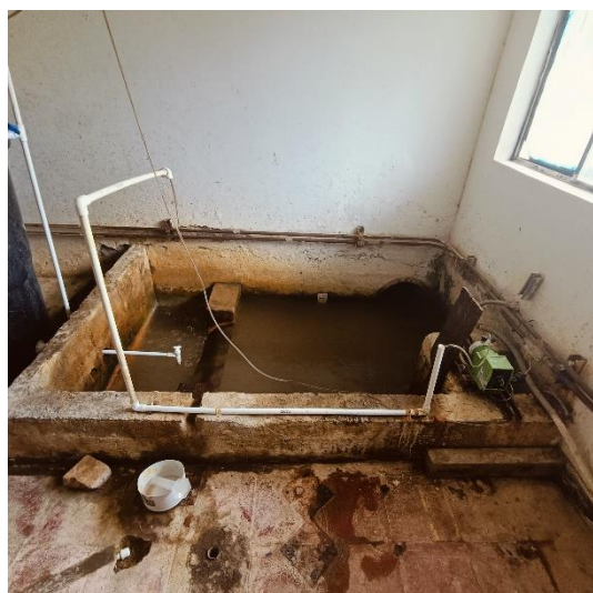
Tanque de ingreso- dosificación
