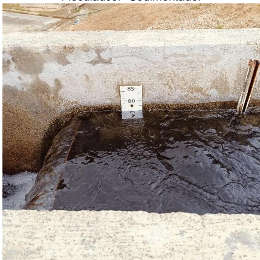
Vertedero de aguas filtradas
