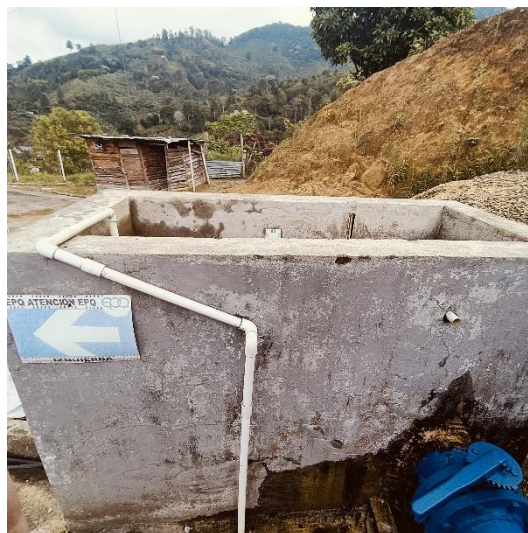
Dosificación de cloro - vertedero salida
