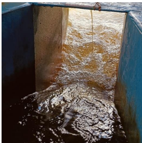
Dosificación de coagulante
