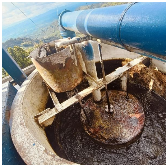
Punto de dosificación de coagulante
