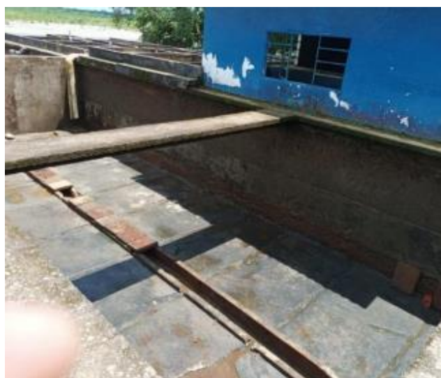
Tanque presedimentación
