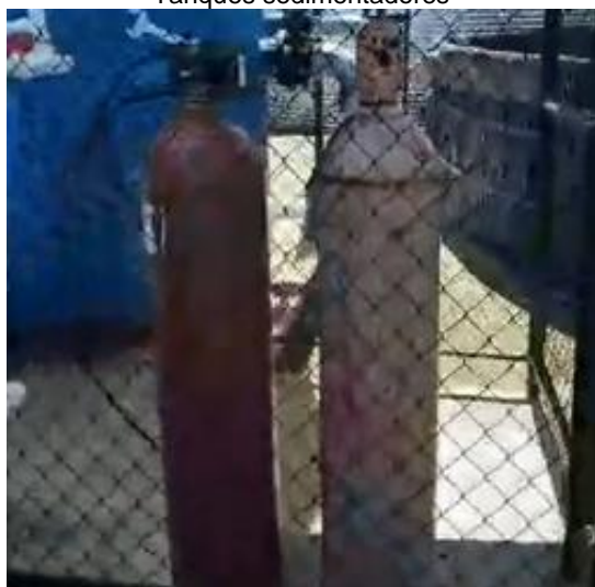
Cilindros cloro gaseoso
