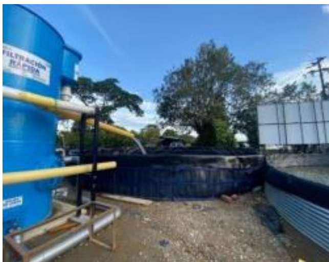
Imagen 10. Tanques nuevos de geomembrana
