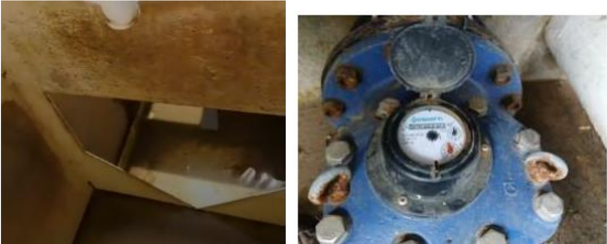
Imagen 7. Vertedero triangular y macromedidor salida planta
