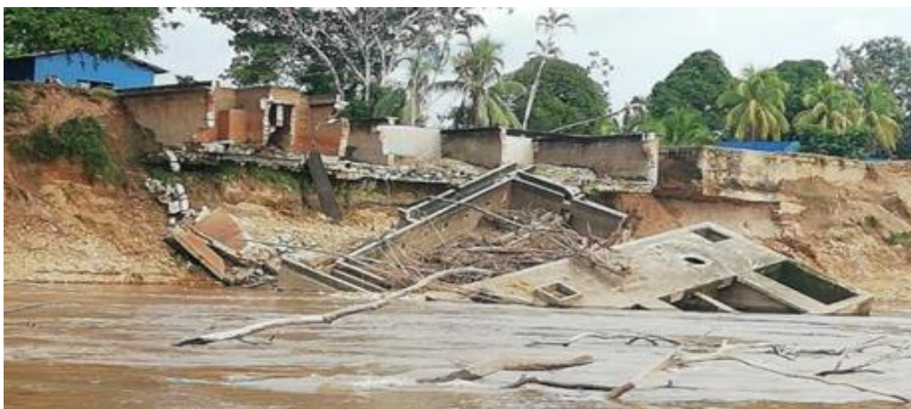
Imagen 3. Colapso planta de tratamiento convencional
