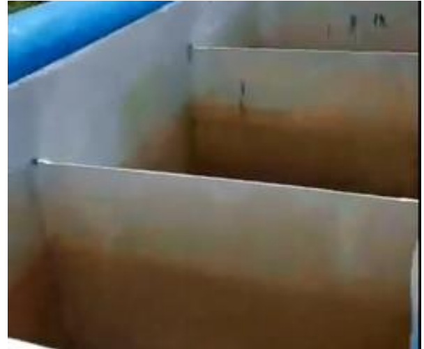
Canaleta mezcla rápida
