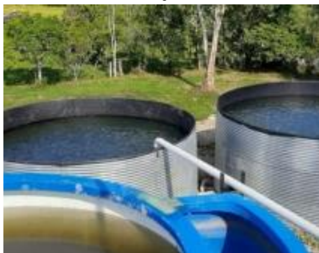
Tanque de almacenamiento geomembrana
