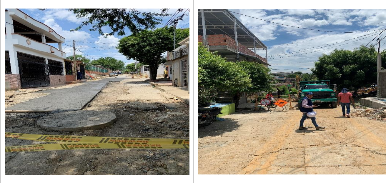
Imagen 12. Obra acueducto y alcantarillado Niña Ceci
