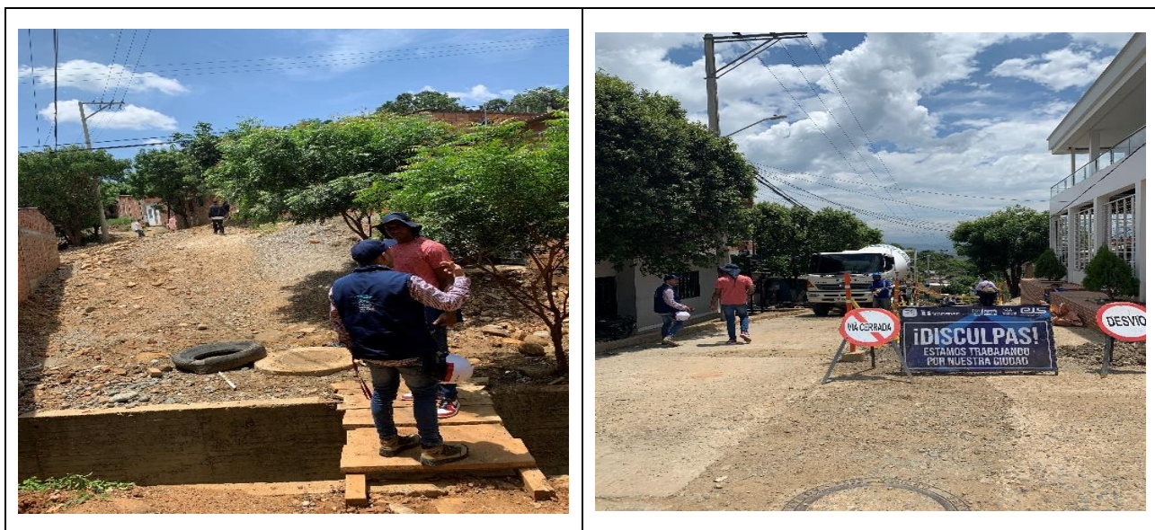
Imagen 13. Obra acueducto y alcantarillado Niña Ceci
