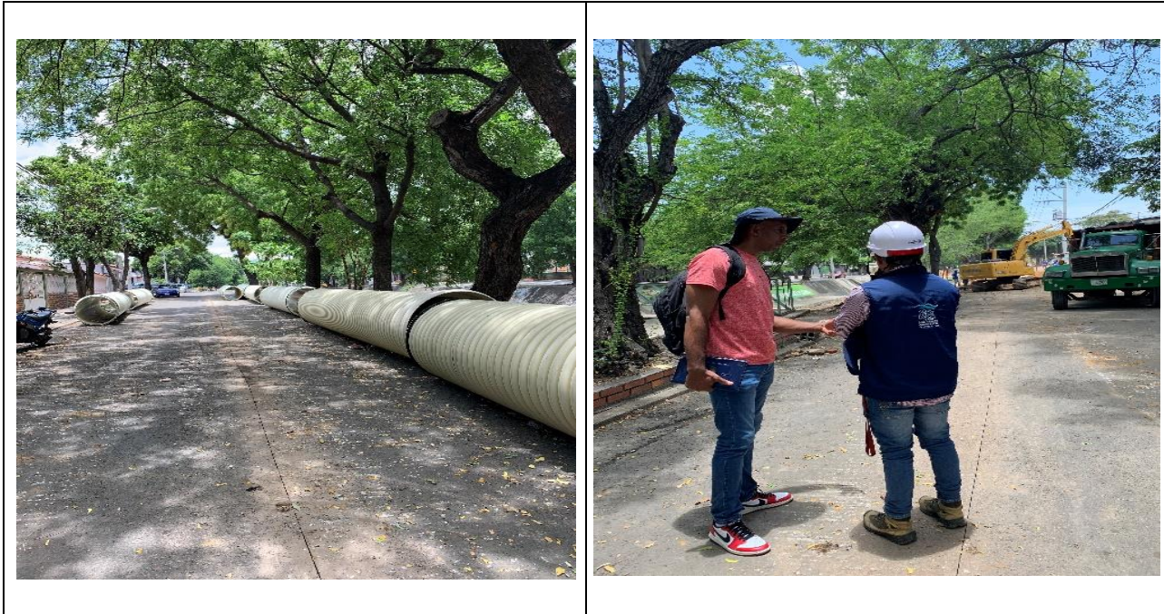
Imagen 11. Obra acueducto y alcantarillado Canal Bogotá
