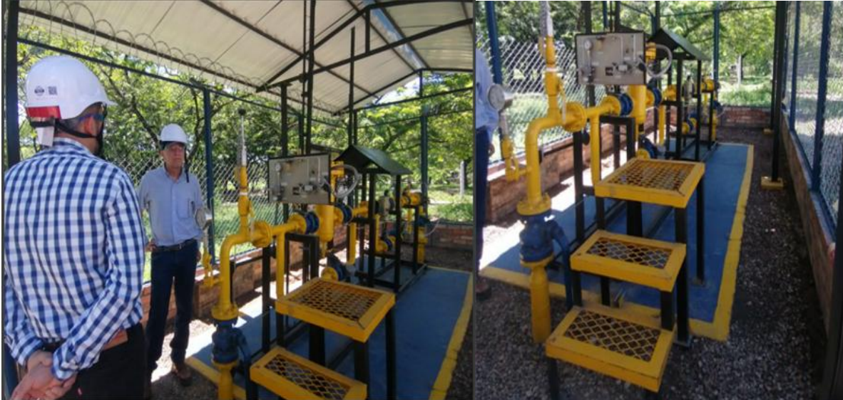
Imagen 2. Estación de Regulación de Presión – ERP
