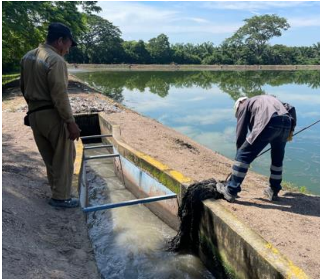
Mantenimiento canaleta Parshall
