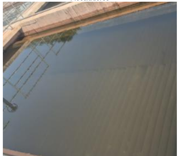
Sedimentador placas
