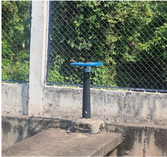
Compuerta desagüe de lodos
