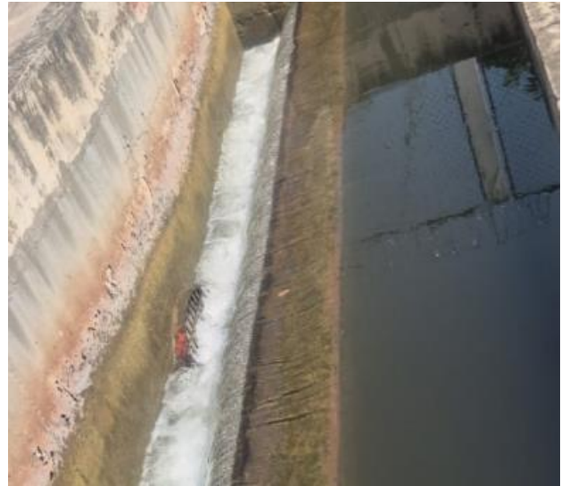
Salida desarenador
