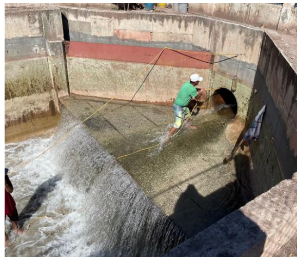
Limpieza entrada desarenador
