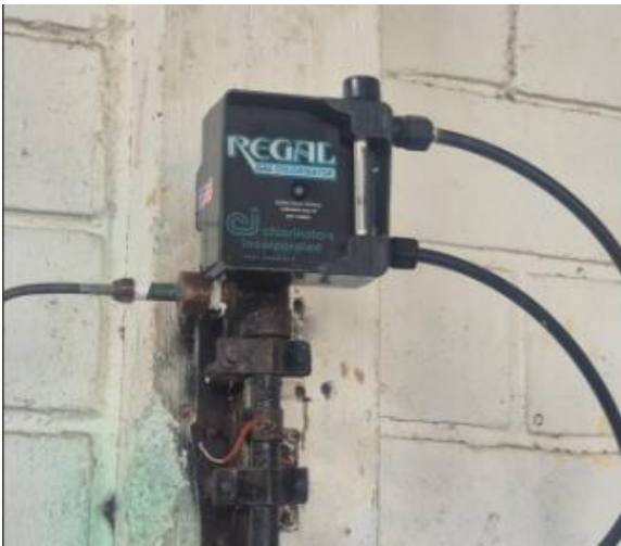
Dosificador cloro gaseoso
