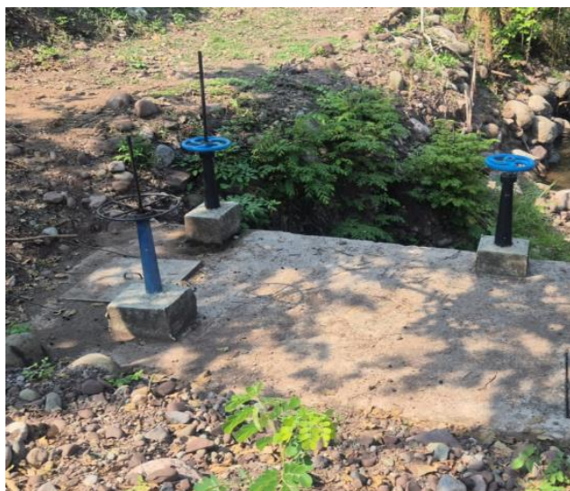
Caja de derivación y compuertas
