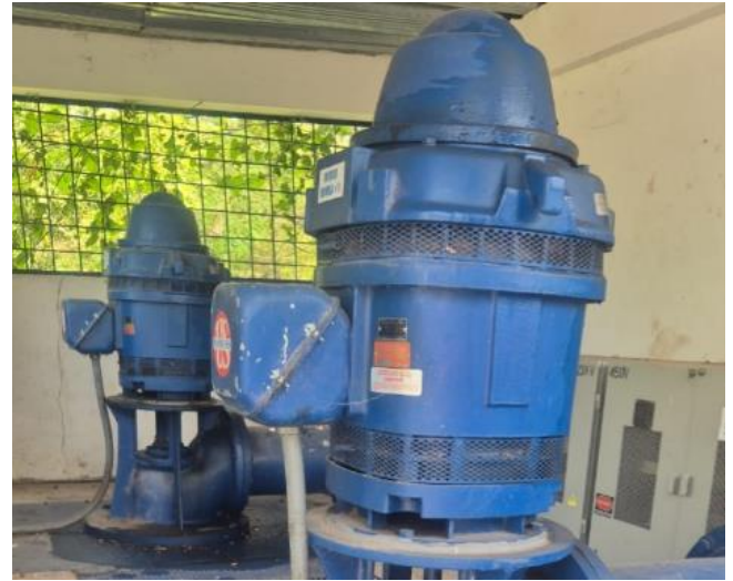
Bombas de succión tanques
