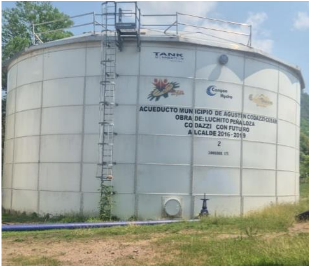
Tanque pernado de 3.000 metros cúbicos
