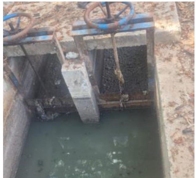
Compuertas al desarenador
