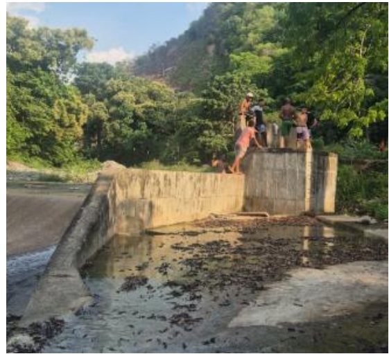
Estructura de captación
