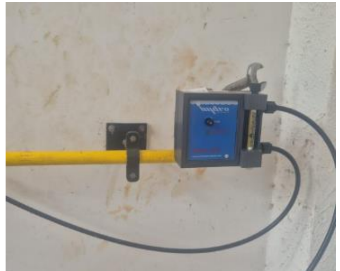
Dosificador cloro gaseoso
