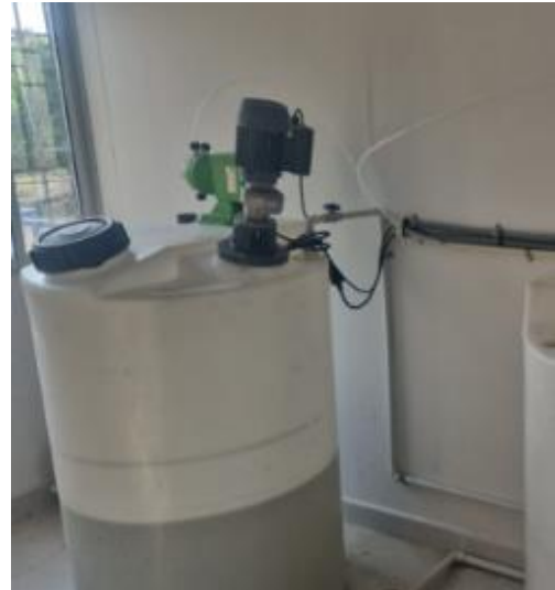
Almacenamiento Policloruro de aluminio
