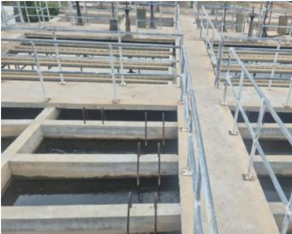
Floculadores y sedimentadores
