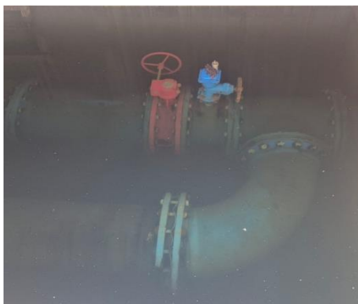
Macromedidor salida planta
