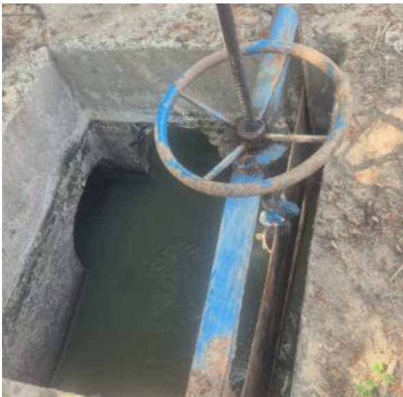
Cámara de llegada y by – pass
