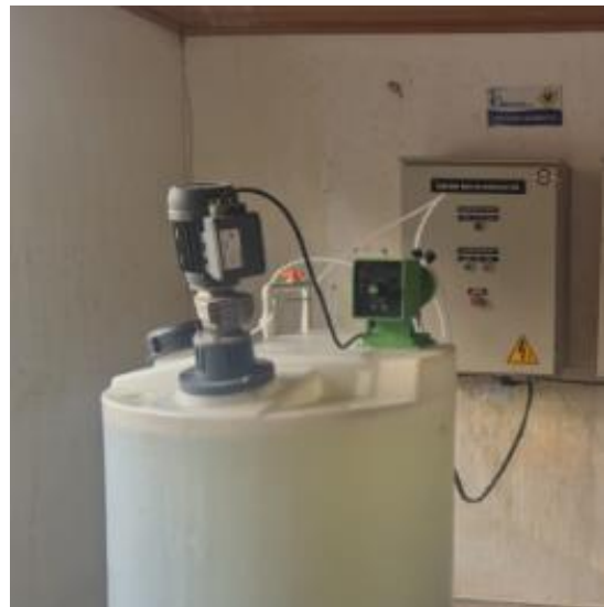
Almacenamiento Policloruro de aluminio
