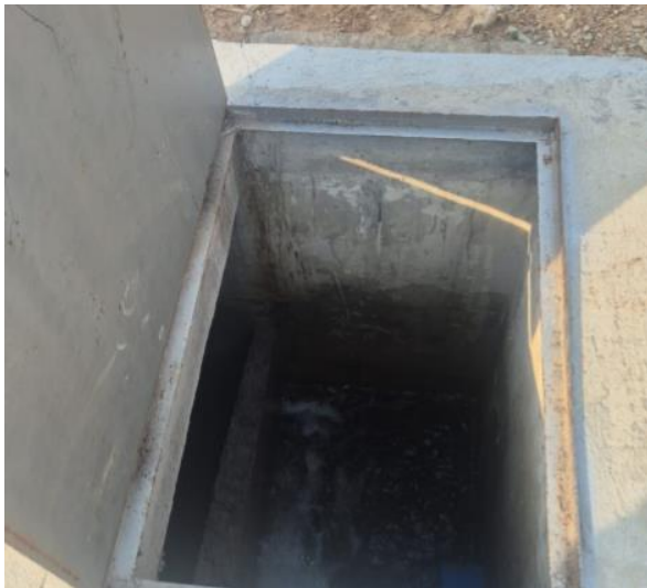
Tanque contacto de cloro
