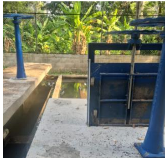
Compuertas entrada desarenador
