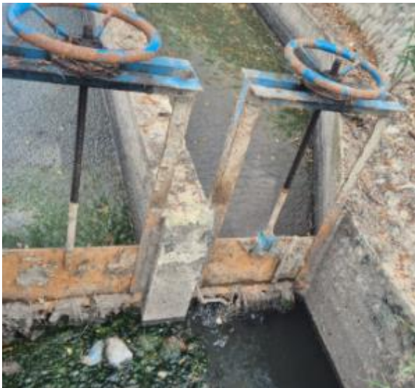
Compuertas salida desarenador
