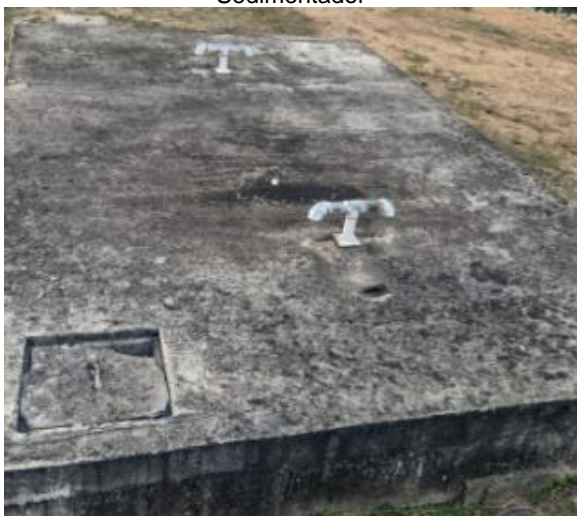
Tanque contacto de cloro
