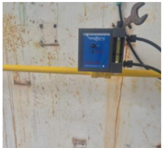
Dosificador cloro gaseoso
