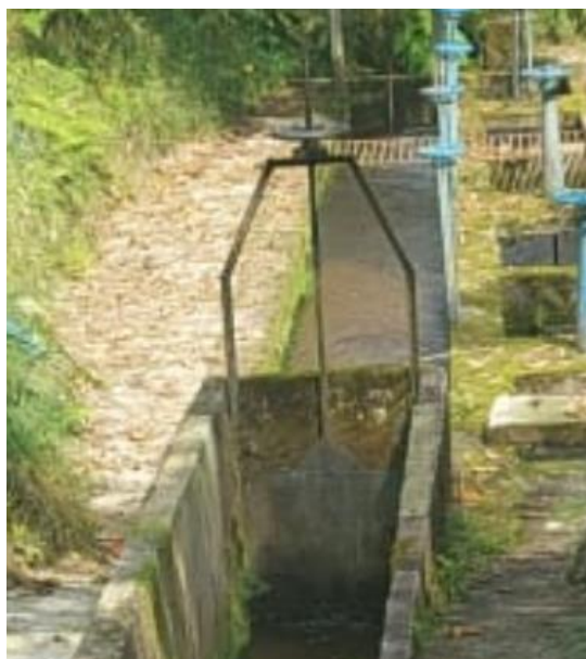
Compuerta tipo guillotina – canal en concreto
