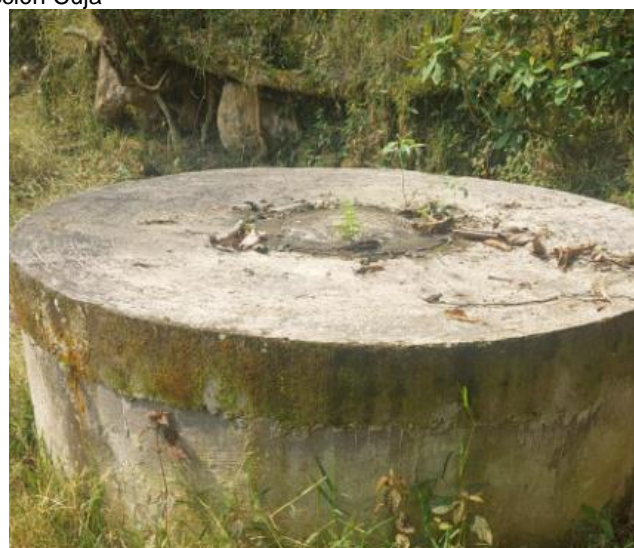
Pozo de inspección para limpieza
