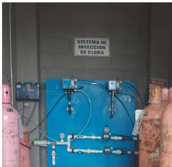
Sistema de inyección de cloro
