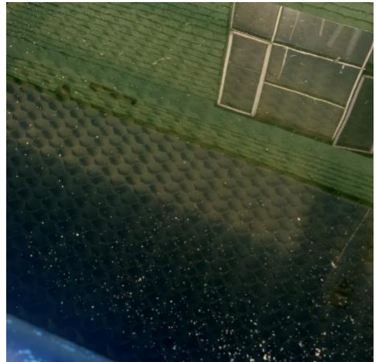
Colmenas sedimentador
