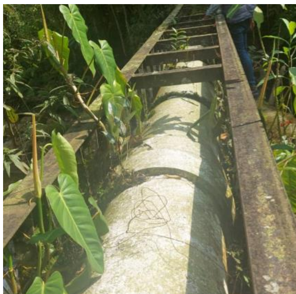
Línea de aducción 18" concreto
