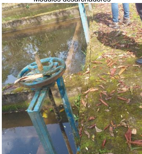
Compuerta tipo guillotina salida desarenador
