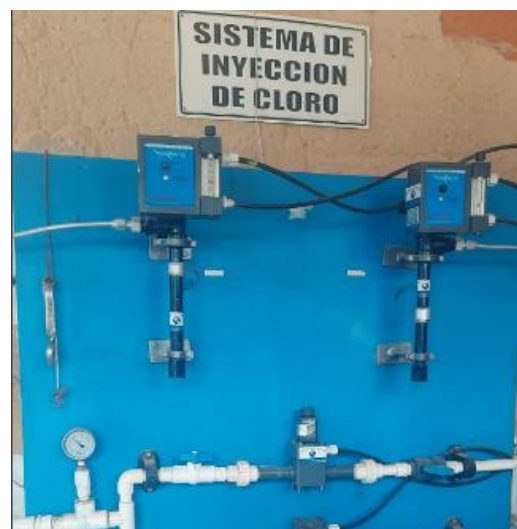
Sistema de inyección de cloro
