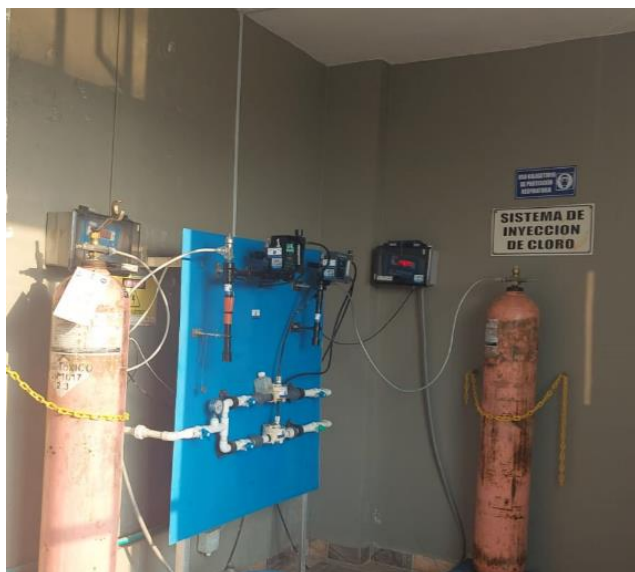
Sistema de inyección de cloro
