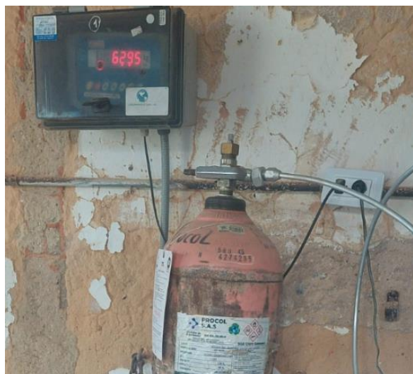
Sistema de inyección de cloro
