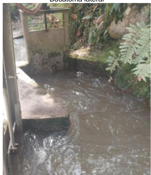
Compuertas tipo guillotina
