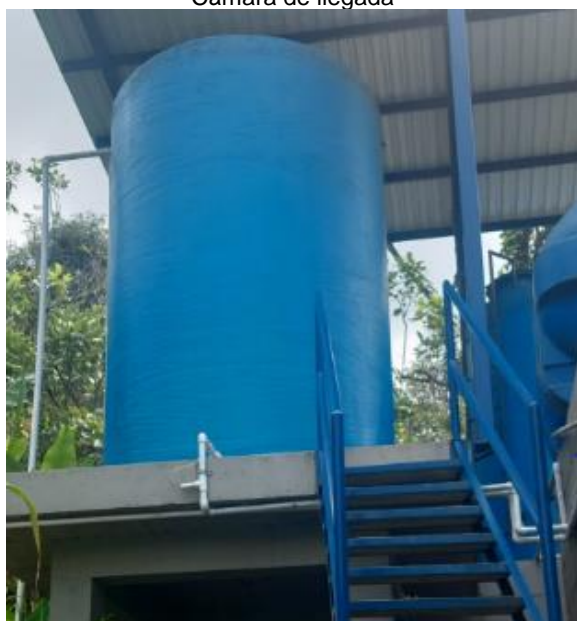
Tanque de almacenamiento hidroxiclورو
