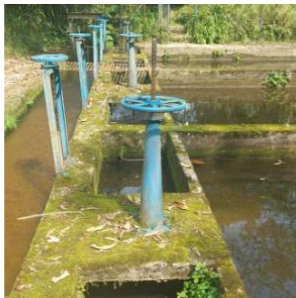
Compuestas tipo guillotina y válvulas de fondo
