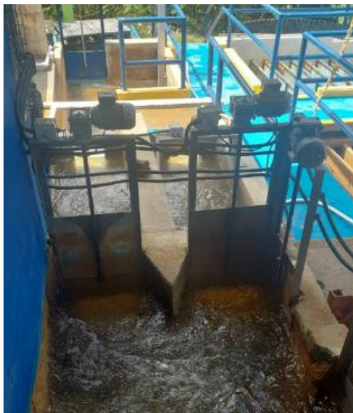
Compuerta electrónica
