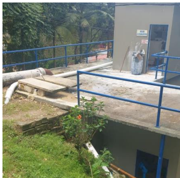
Tanque contacto de cloro
