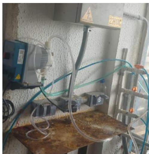
Dosificador de sulfato granular
