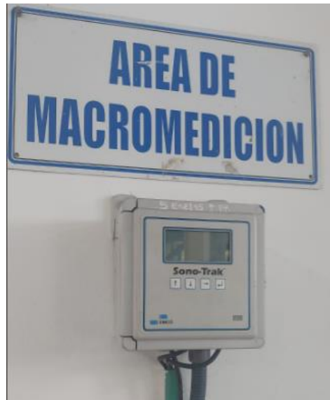
Macromedidor entrada PTAP fuera de funcionamiento
