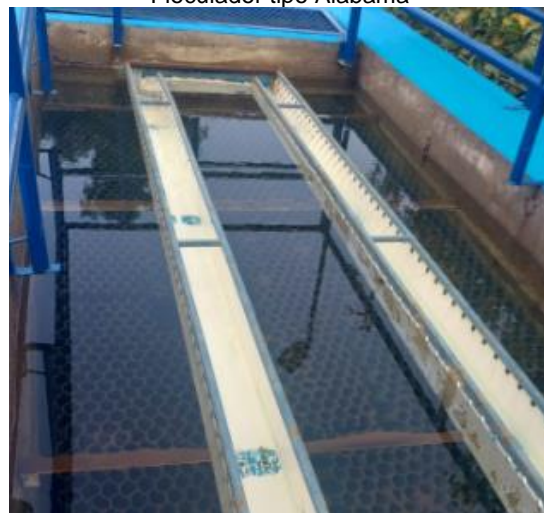
Sedimentador alta tasa tipo colmena
