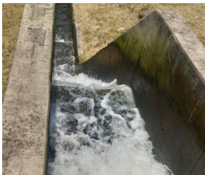
Cabezal de descarga
