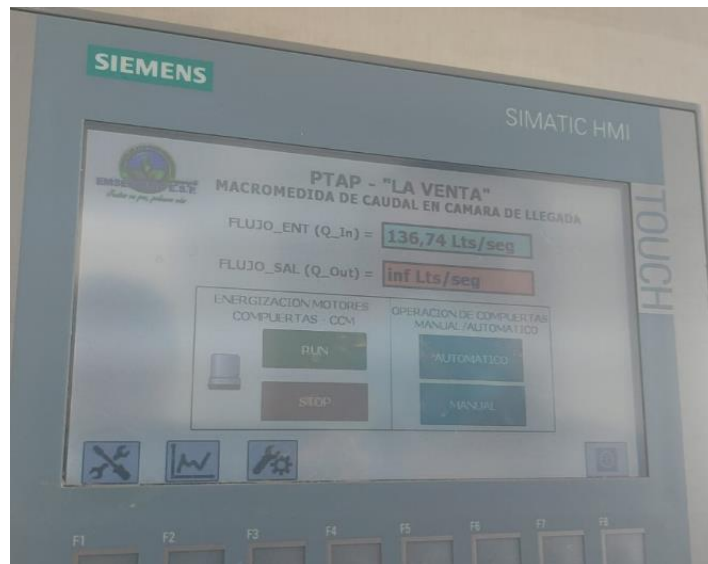
Equipo visualización caudal de entrada
