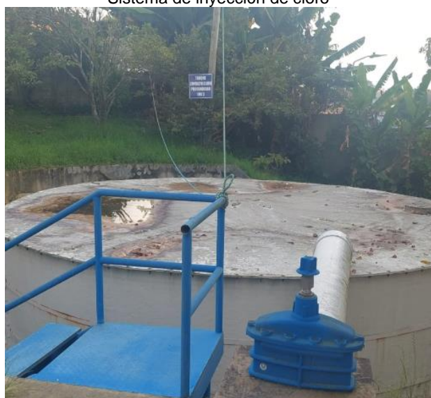
Tanques contacto de cloro
