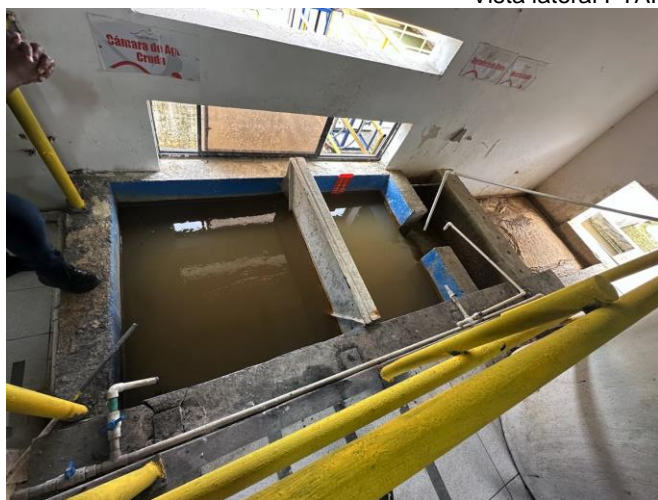
Canal de ingreso a la PTAP, regleta medición caudal de entrada y dosificación químico
