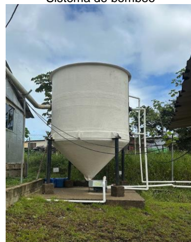
Tanque para lavado de filtros
