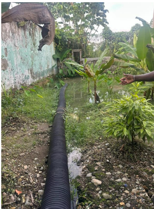
Tubería descarga de la EBAR
