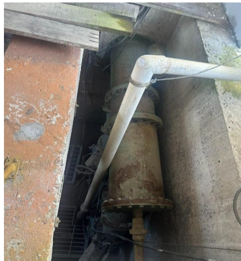
Tubería de ingreso a la EBAR
