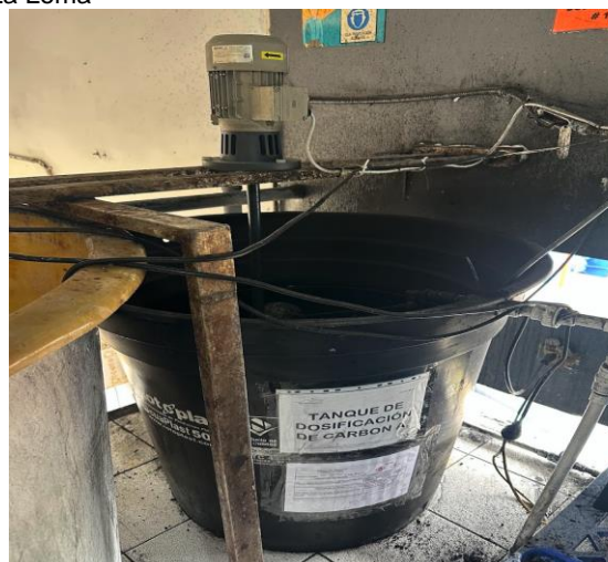
Tanque dosificador de carbón
