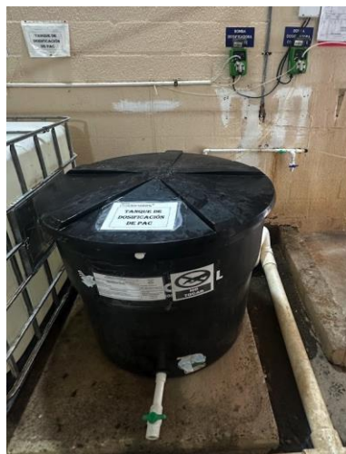
Tanque y bombas dosificadoras de PAC
