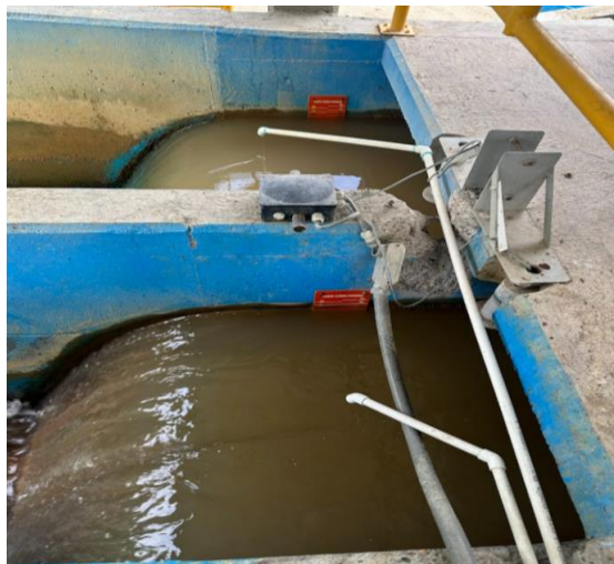
Punto de dosificación químicos y regletas medición caudal de ingreso
