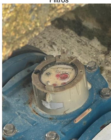
Macromedidor a la salida de la PTAP
