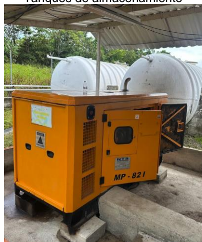
Planta eléctrica de respaldo
