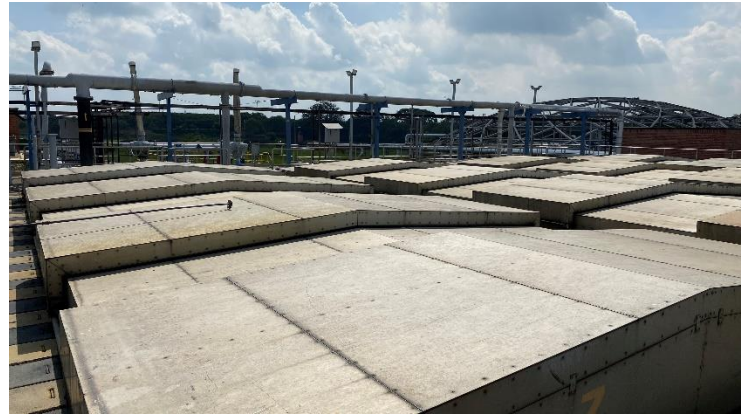
Desarenador aireado
