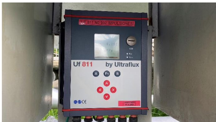
Transmisor de flujo entrada a la PTAR-C
