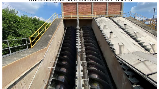
Bombas elevadoras tipo tornillo
