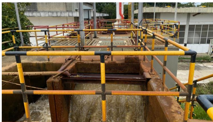
Punto de dosificación de coagulante y mezcla rápida
