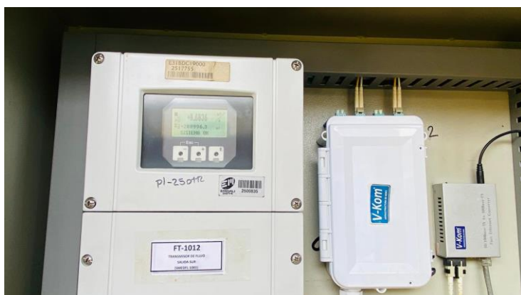
Transmisor de flujo de la salida Sur de la PTAP Río Cauca
