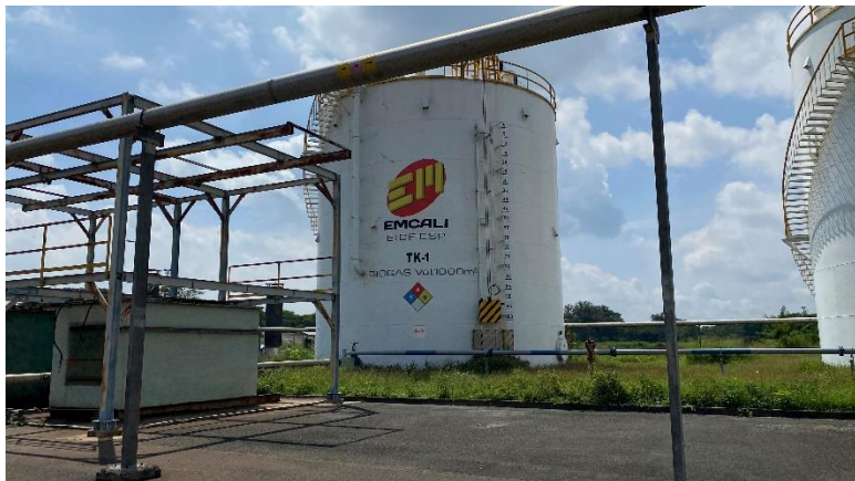
Tanque de almacenamiento de biogás
