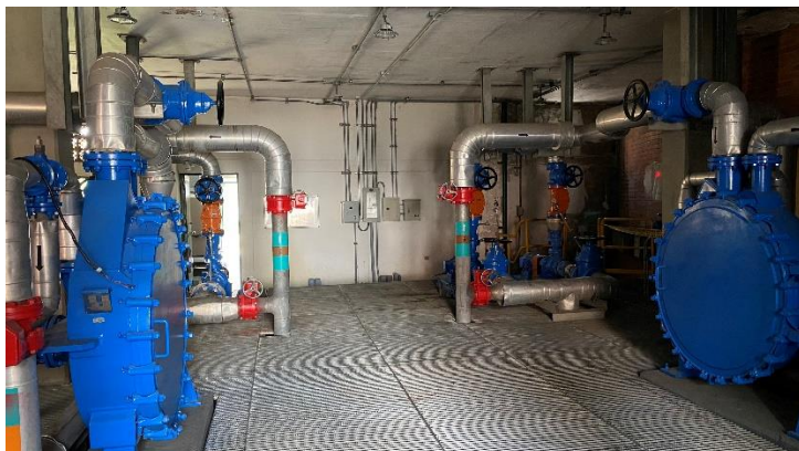
Sistema de calentamiento Digestor anaerobio
