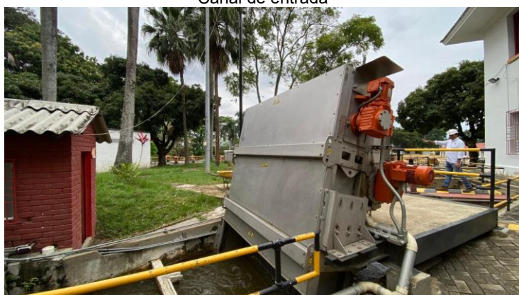
Cribado fino automatizado
