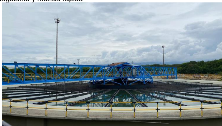
Reactor de manto de lodos
