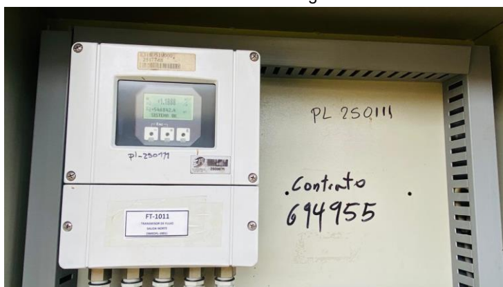
Transmisor de flujo de la salida Norte de la PTAP Río Cauca
