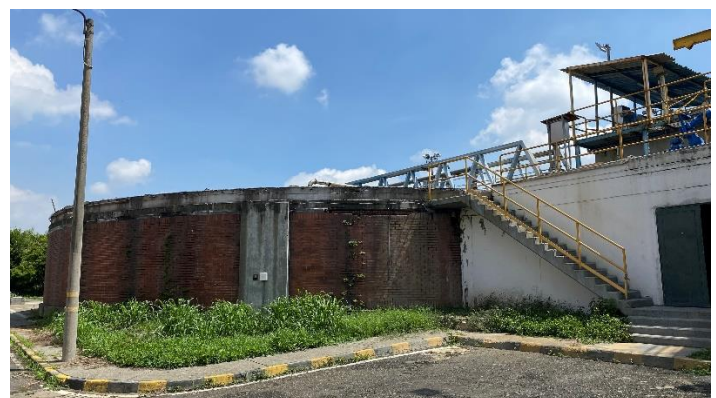
Espesador de lodos
