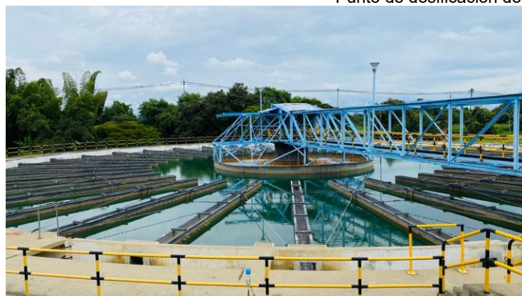
Reactor de manto de lodos
