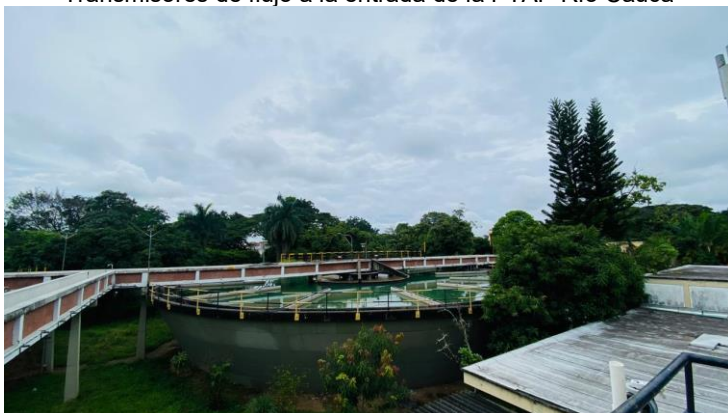
Reactor de manto de lodos
