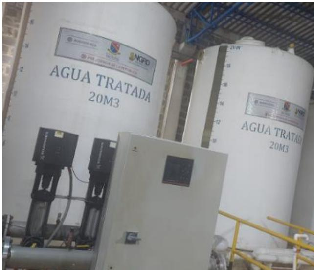
Tanque de agua tratada de 20 m<sup>3</sup> y Sistema de bombeo Grundfos
