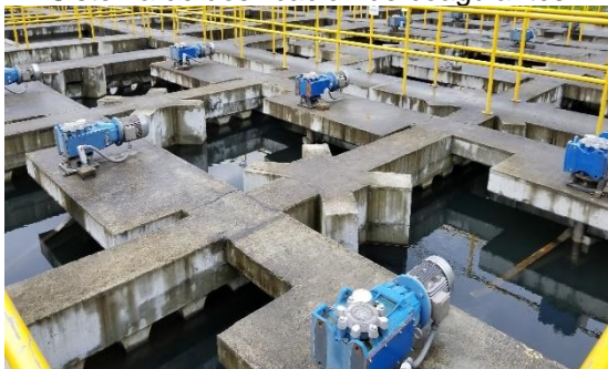
Floculadores mecánicos de eje vertical
