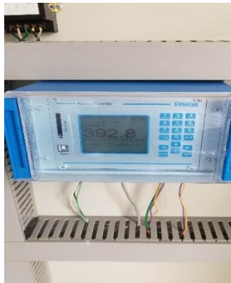
Medición de caudal a la salida de la planta Fuente: Registro fotográfico SSPD – visita SSPD
