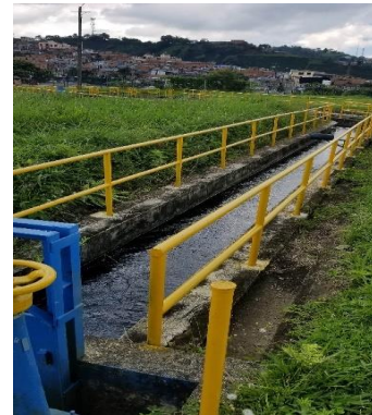
Caudal entregado a Serviciudad
