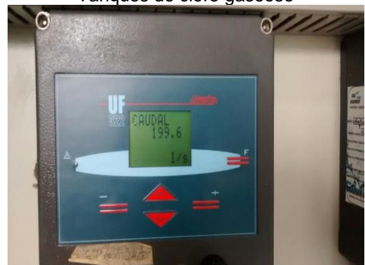
Medición de caudal de salida de la planta
