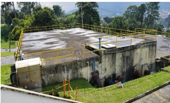
Tanque de contacto de cloro
