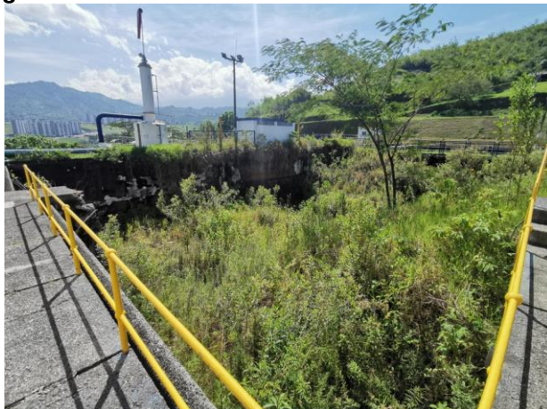
Imagen 12. Planta de tratamiento Aurora Fuera de servicio.
