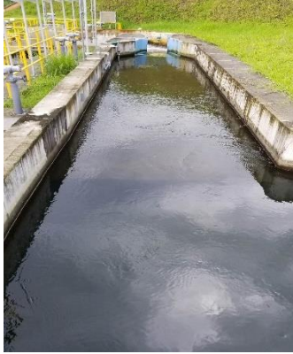
Canal de entrada a la planta
