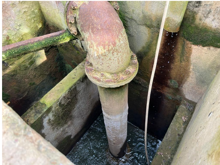
Imagen 13. Estructuras de ingreso a la PTAP.
