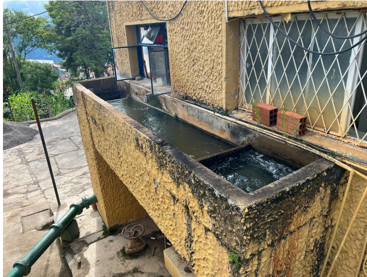
Imagen 14. Canaleta de entrada.
