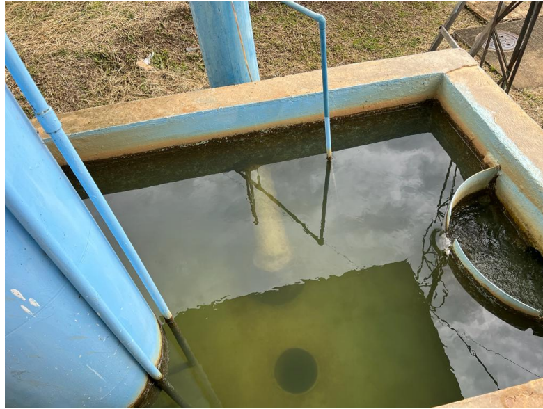
Imagen 22. Unidades de filtración.
