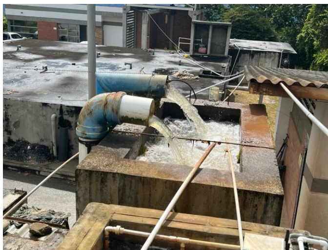
Imagen 24. Estructura de entrada PTAP Cinco Mil.
