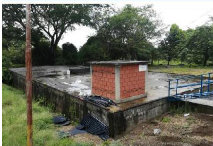
Imagen 15. Tanque de almacenamiento
