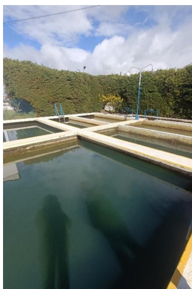
Sedimentador convencional
