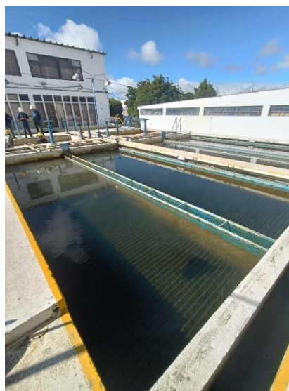
Sedimentador alta tasa
