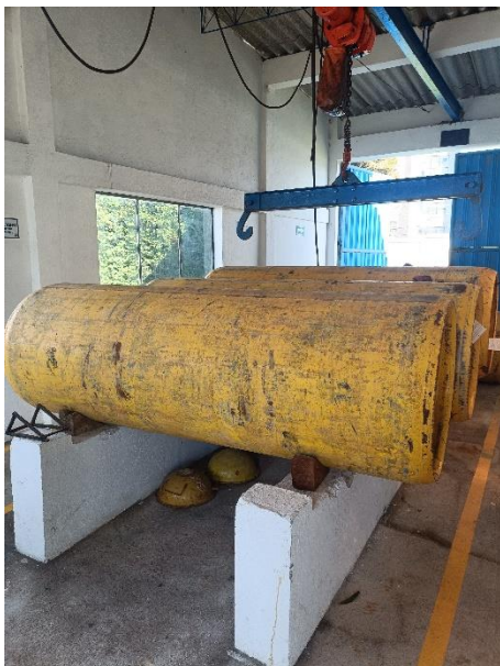
Cilindros de cloro gaseoso
