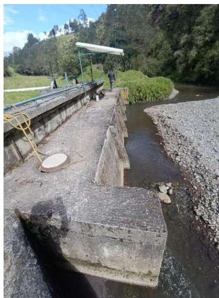
Estructura de captación
