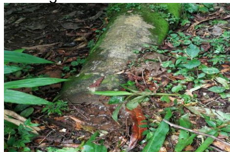
Fuga tubería de aducción de 8"
