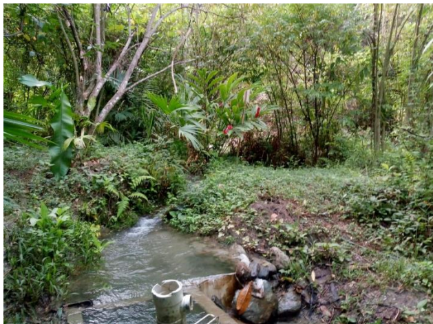
Imagen 4. Captación Quebrada La Barbuda – Olaya.
