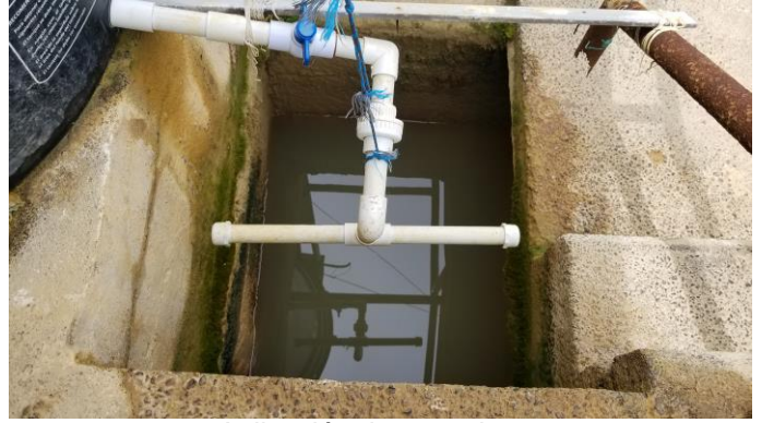
Aplicación de coagulante
