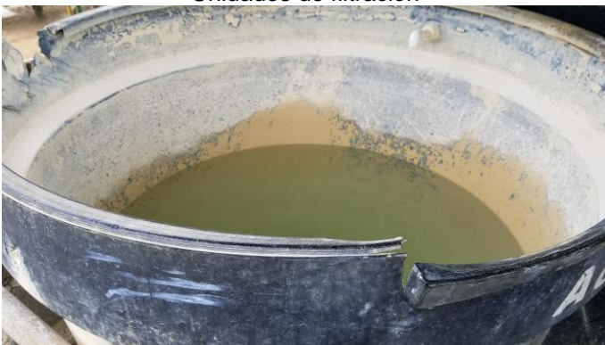
Tanque de almacenamiento de solución de cloro
