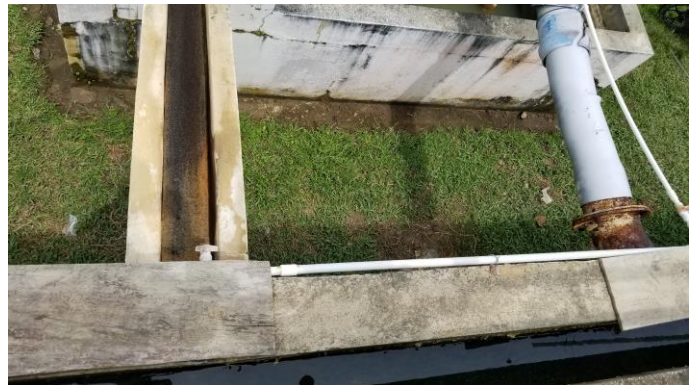
Aplicación de cloro
