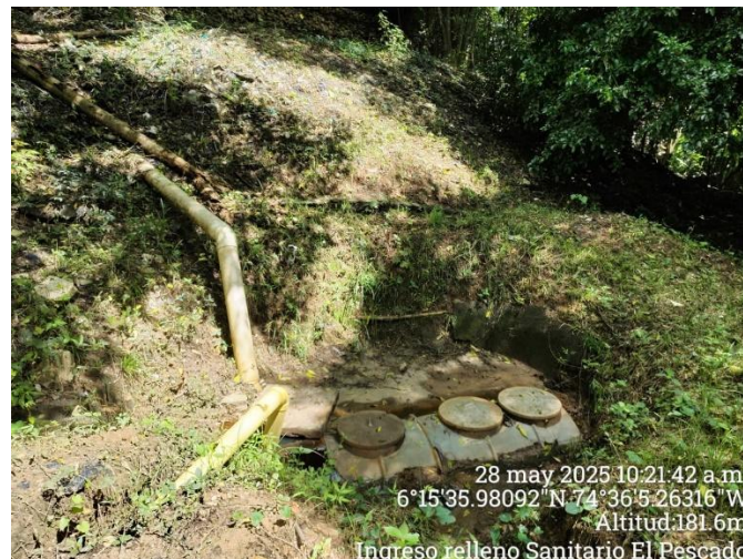
Foto 65 FAFA fuera de funcionamiento
