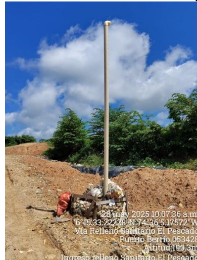
Foto 59 Ducto de evacuación de gas
