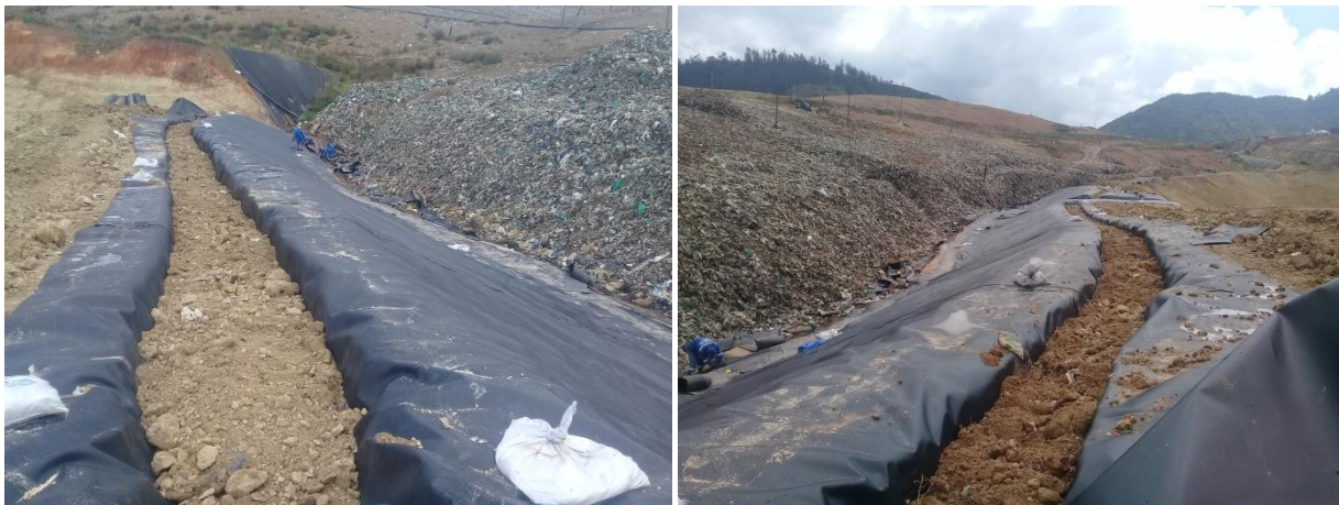
Foto 20 Avance en la impermeabilización del talud de la terraza 2 adyacente a la adecuación de la terraza 1C.
