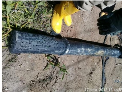
Foto 12 Mantenimiento a bomba sumergible - Chimenea No. CH 1044
