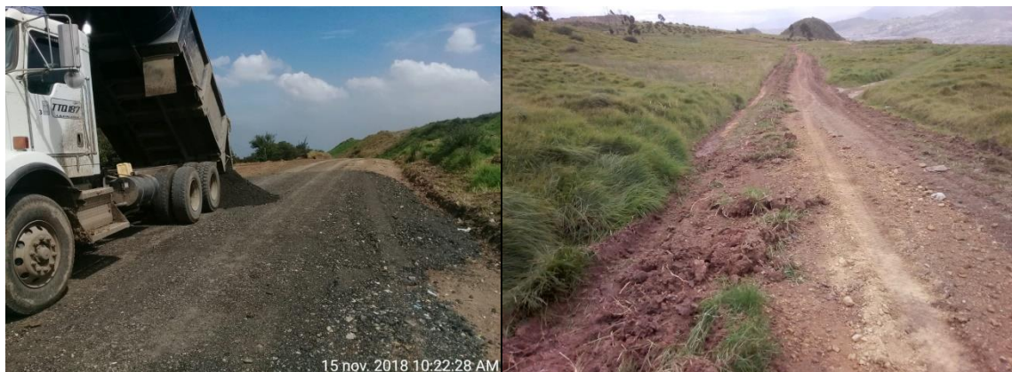
Foto 28 Mantenimiento de vía Puente Tierra con material de fresado (izquierda) y mantenimiento de bermas en Zona II – Área 1 (derecha).
