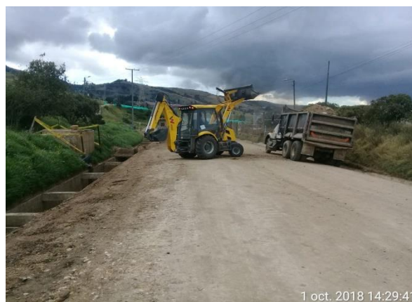
Foto 30 Retrocargador y volqueta doble troque alquilados como apoyo a labores de mantenimiento de vías operativas.
