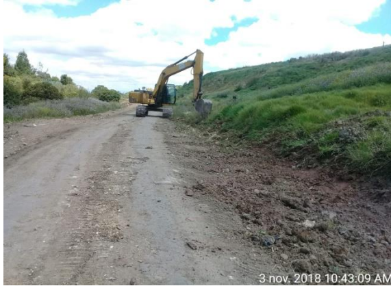
Foto 29 Ampliación del ancho de la vía operativa en el sector de Puente Tierra.
