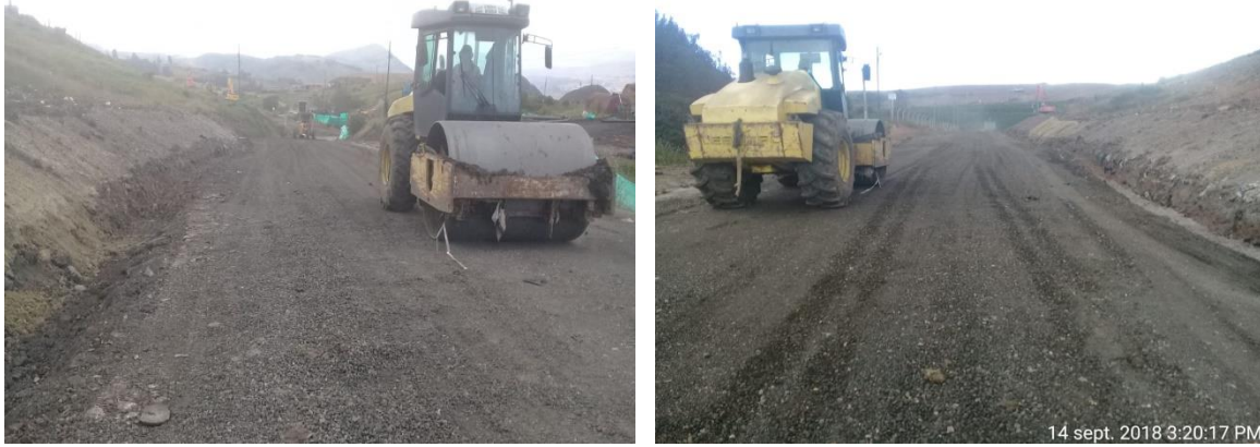
Foto 31 Vibrocompactador alquilado para el mantenimiento de las vías operativas.
