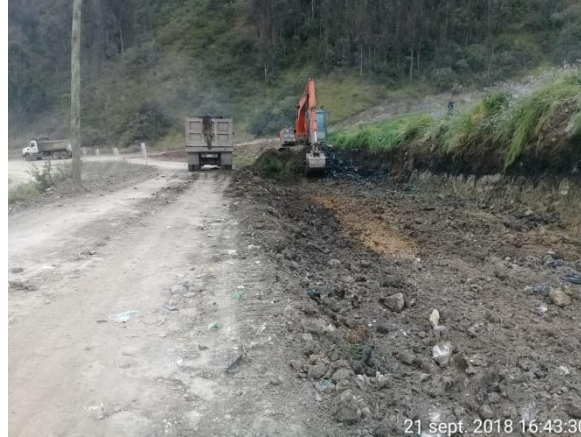
Foto 26 Ampliación del ancho de las vías operativas.
