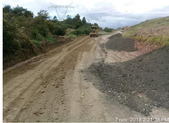
Foto 29 Ampliación del ancho de la vía operativa en el sector de Puente Tierra.
