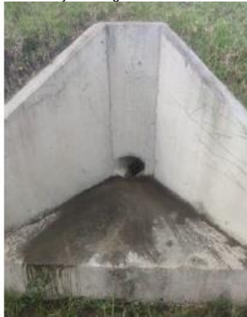
Estrutura de descarga
