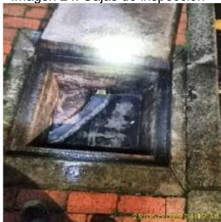
Imagen 24. Cajas de inspección
