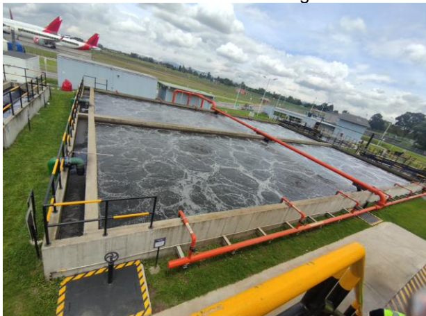
Tanques de aireación
