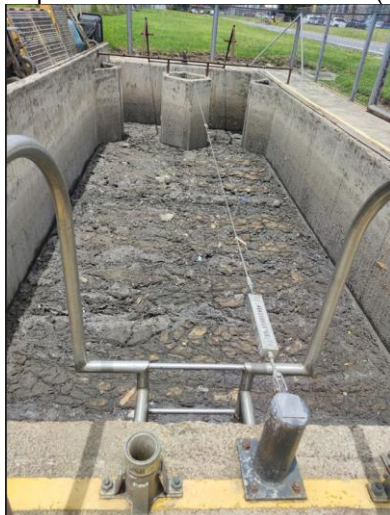
Cámara de retención de sólidos
