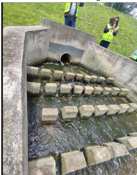
Cabezal de Descarga de AR
