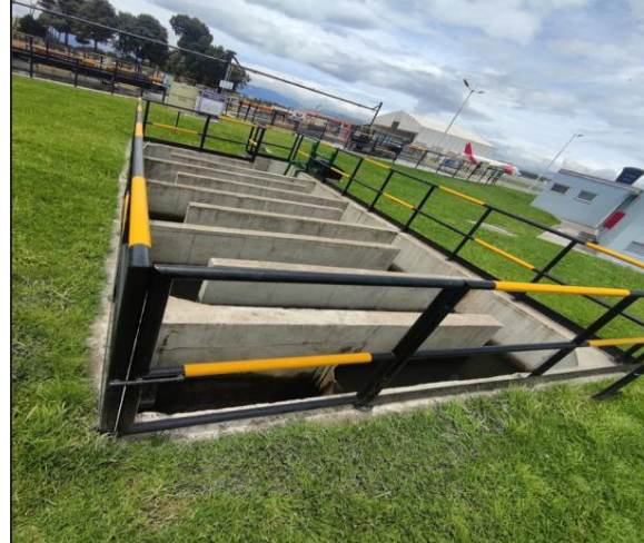
Tanque contacto de cloro
