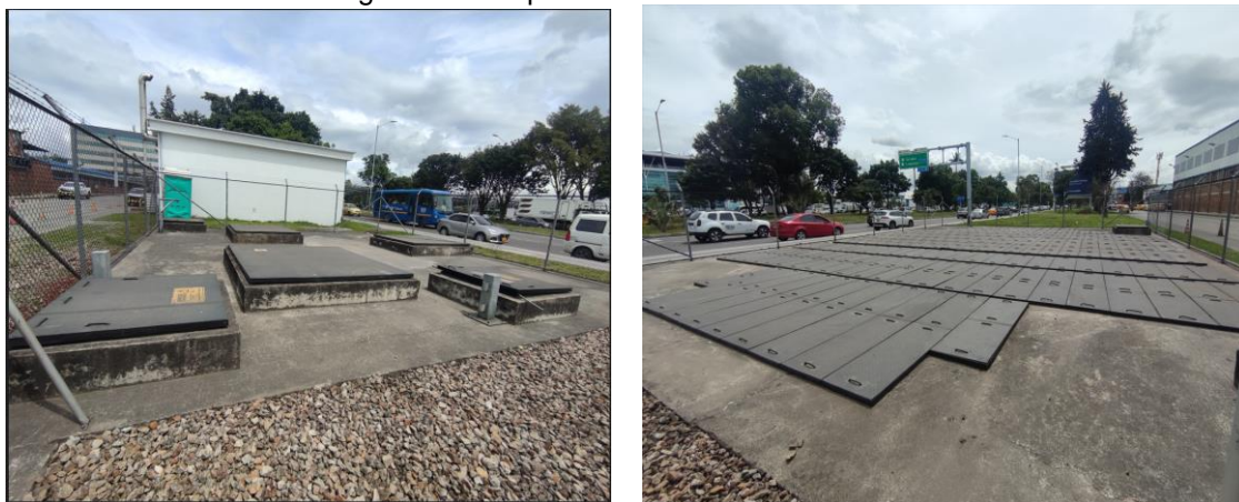
Tapas de inspección de concreto y metálicas para el acceso a cámaras subterráneas.
