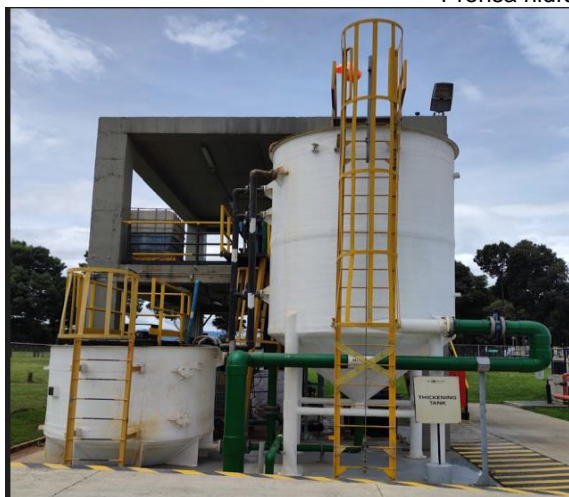
Tanque de ajuste de lodos
