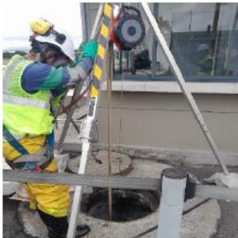
Imagen 22. Pozo de inspección
