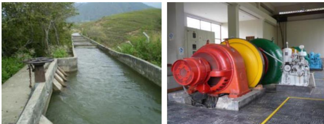
Imagen 4. Canal de conducción y equipo turbogenerador
