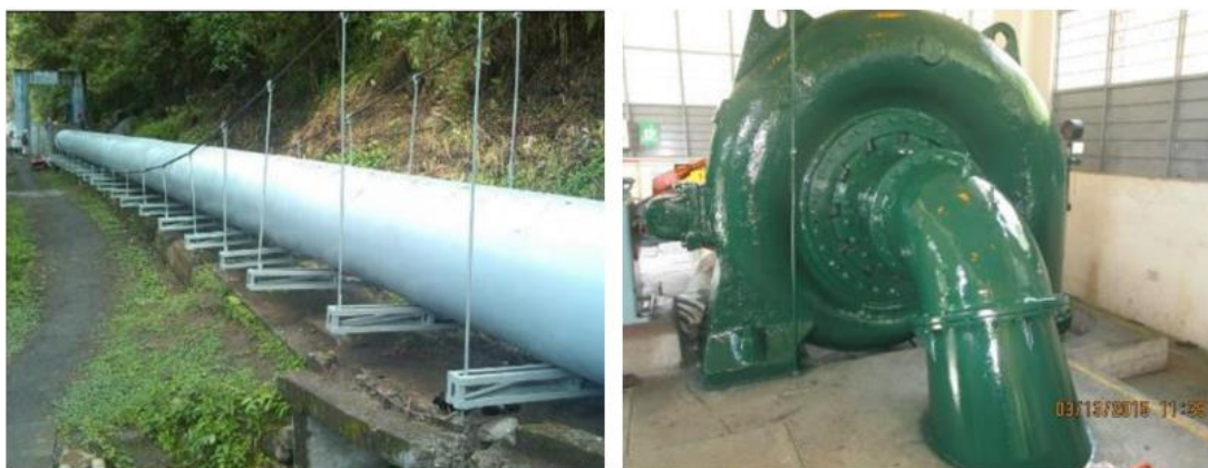
Imagen 9. Tubería de presión y turbina
