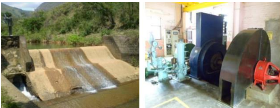
Imagen 6. Bocatoma y equipo turbogenerador
