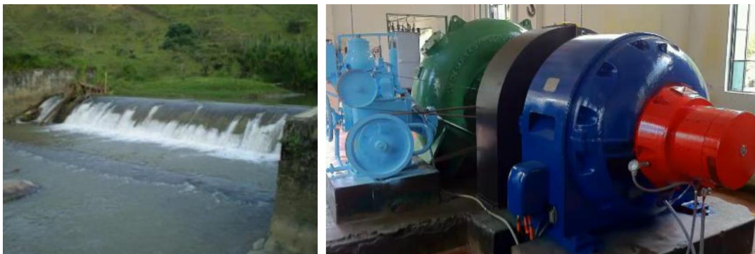
Imagen 8. Bocatoma y equipo turbogenerador
