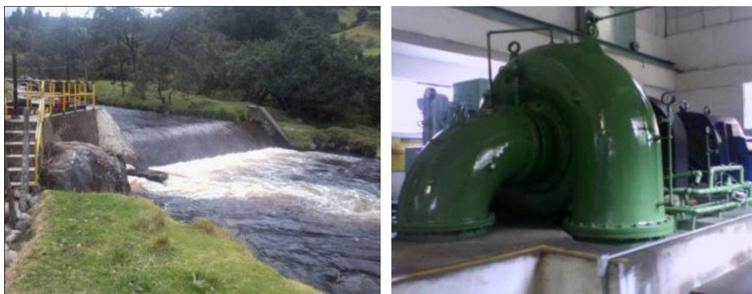
Imagen 7. Bocatoma y equipo turbogenerador
