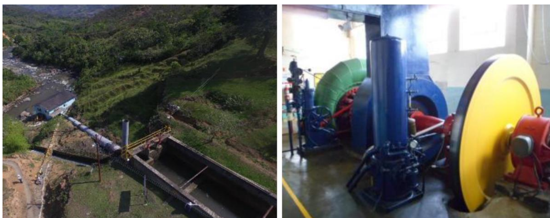
Imagen 5. Tubería de presión y equipo turbogenerador
