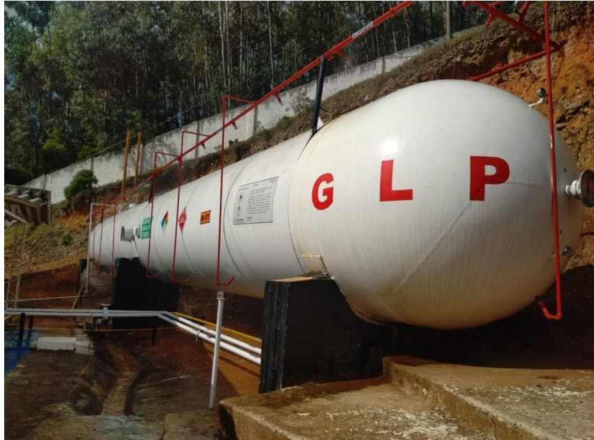
Figura 9. Tanques estacionarios de almacenamiento y drenaje de la planta de envasado de la empresa GRAGOS en Sogamoso, Boyacá.
