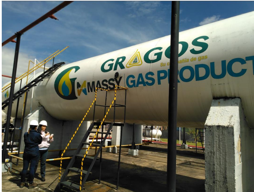
Figura 10. Tanques estacionarios de almacenamiento y drenaje de la planta de envasado de la empresa GRAGOS en Paipa, Boyacá.
