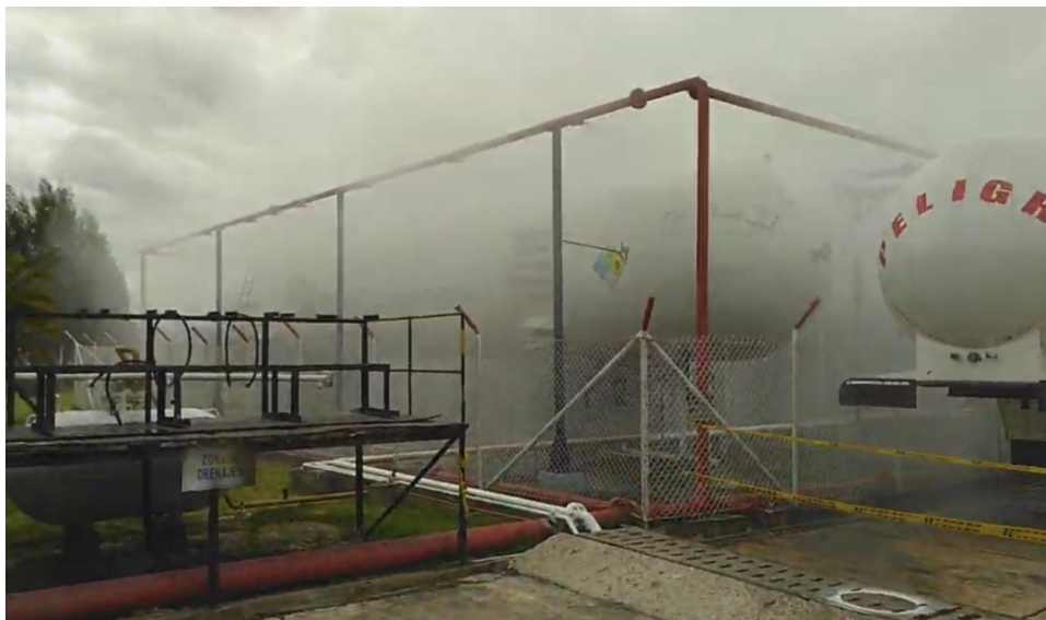
Figura 6. Prueba de la red contra incendios para el tanque de almacenamiento de GLP en la planta de envasado de GRAGOS en Paipa, Boyacá
