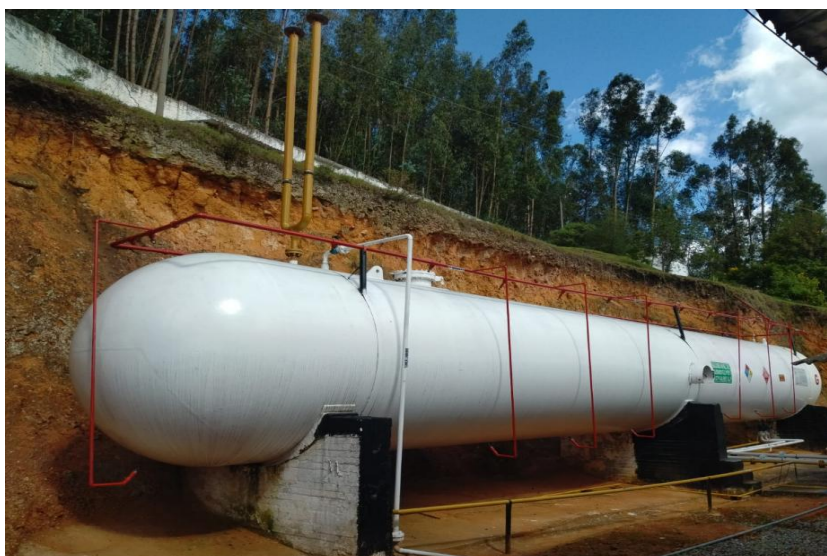
Figura 4. Prueba de la red contra incendios para el tanque de almacenamiento de GLP en la planta de envasado de GRAGOS en Sogamoso, Boyacá
