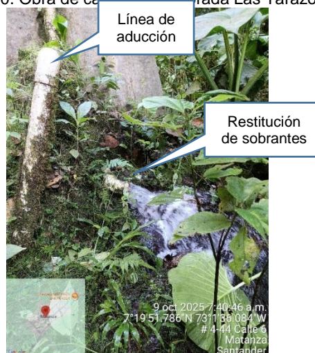
Imagen 20. Obra de captación quebrada Las Tarazonas
