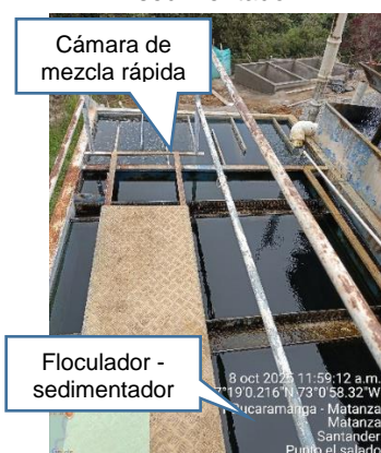
Imagen 30. Cámara de mezcla rápida y floculador – sedimentador
