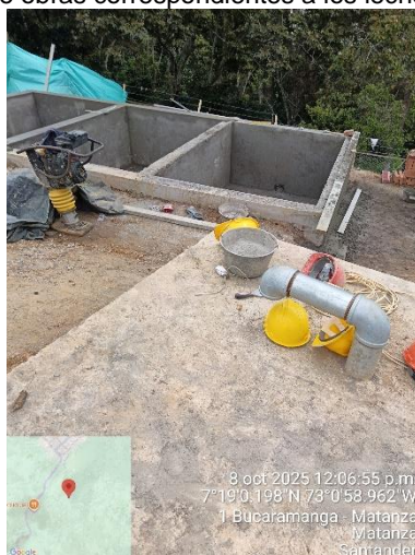
Imagen 35. Avance de obras correspondientes a los lechos de secado de lodos
