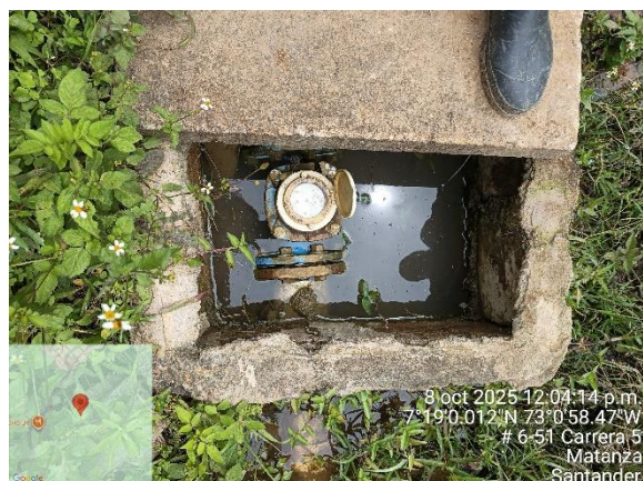
Imagen 37. Macromedidor entrada a PTAP fuera de operación
