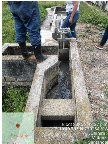
Imagen 46. Sistema de ingreso a la PTAR
