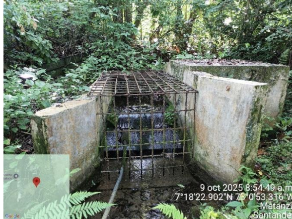
Imagen 10. Obra de captación de quebrada Agua Dulce
