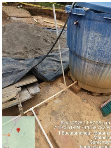
Imagen 32. Tanque de preparación de la solución de cloro para la desinfección
