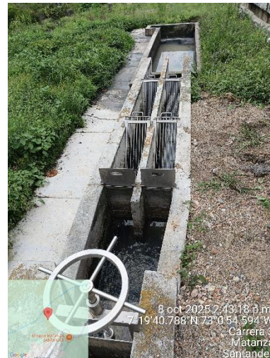
Imagen 47. Estructura de cribado y trampa de grasas
