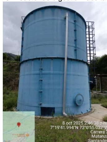
Imagen 48. Reactor de digestión facultativa mixta
