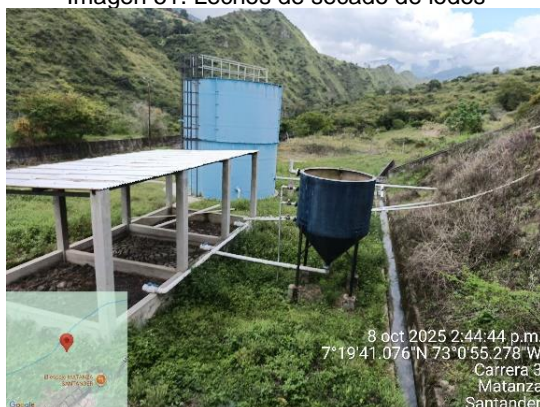
Imagen 51. Lechos de secado de lodos
