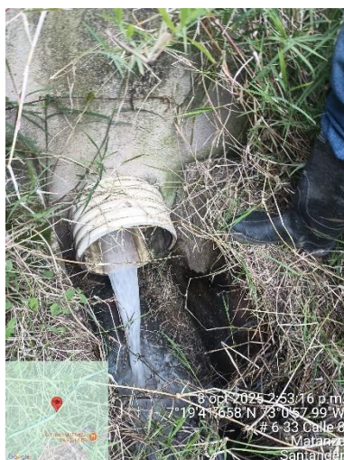
Imagen 52. Salida de la PTAR
