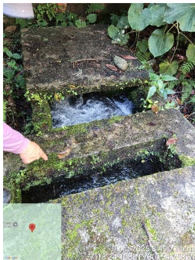
Imagen 11. Cámara de entrada al desarenador
