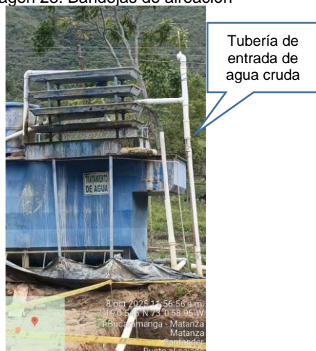
Imagen 28. Bandejas de aireación
