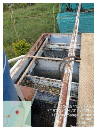
Imagen 31. Tanques de filtración
