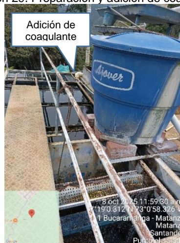
Imagen 29. Preparación y adición de coagulante
