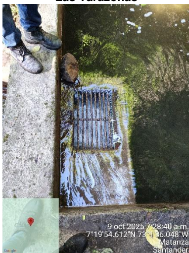
Imagen 15. Rejilla obra de captación de quebrada Las Tarazonas
