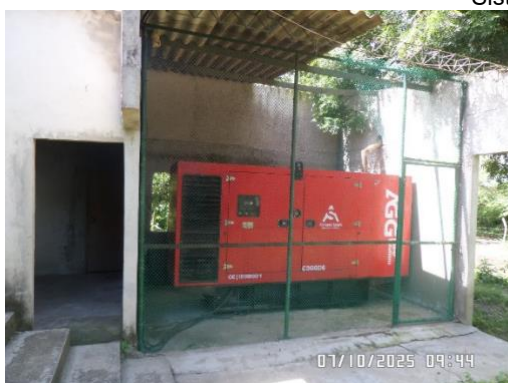
Generador eléctrico de respaldo
