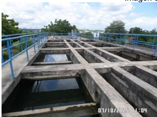
Tanques sedimentadores
