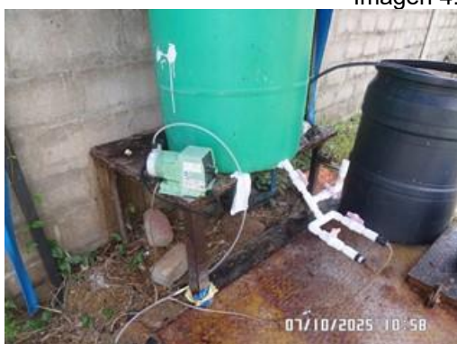
Tanque almacenamiento coagulante
