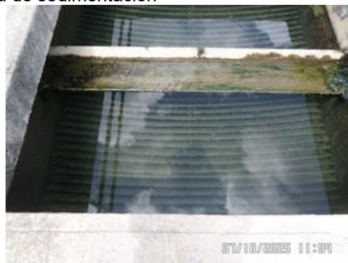
Placas que conforman los sedimentadores
