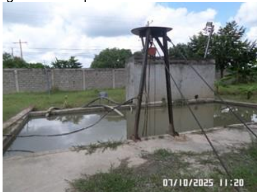
Imagen 12. Tanque de almacenamiento de lodos
