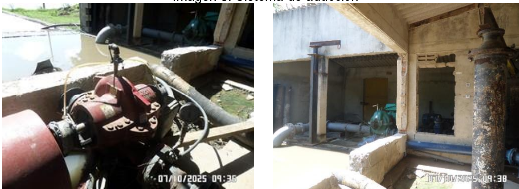
Tanque de succión y equipo de bombeo
