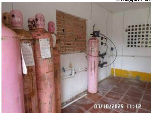
Pipetas de cloro gaseoso
