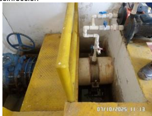
Estructura dosificación del desinfectante
