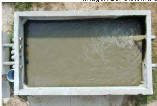
Tanque desarenador –
