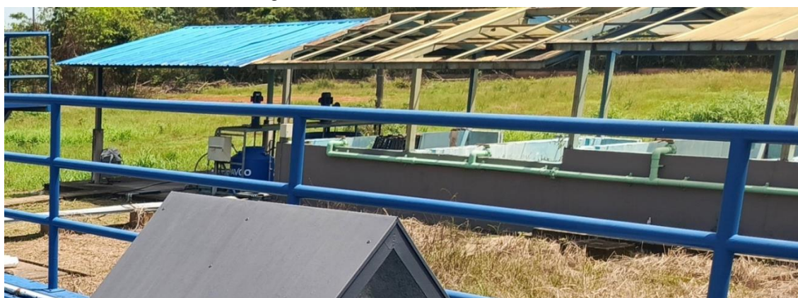
Imagen 43. Lechos de secado de lodos.
