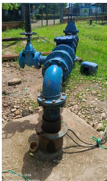
Tubería de salida agua cruda pozo
