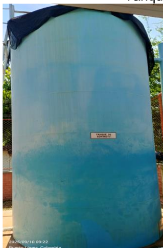
Tanque de contacto de 12.000 l
