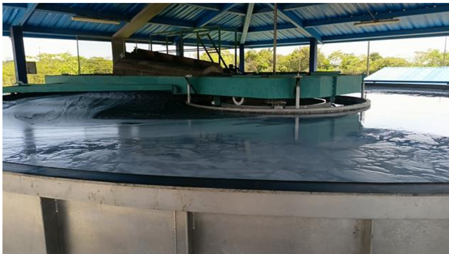
Imagen 41. Tanque mezclador.
