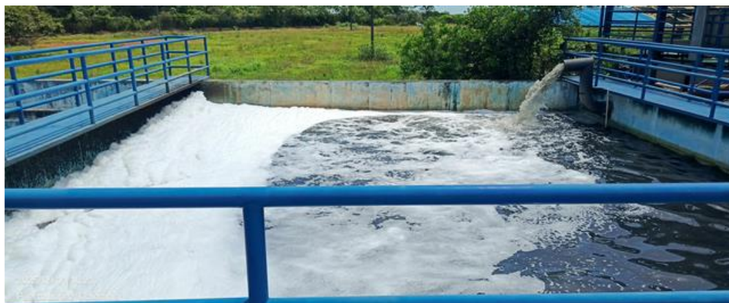
Imagen 42: Tanque de desinfección.
