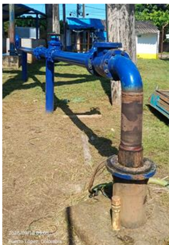
Tubería de salida agua cruda pozo
