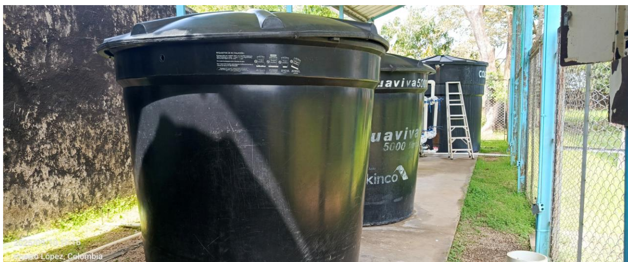
Vista de tanques de 10.000 y 5.000 litros
