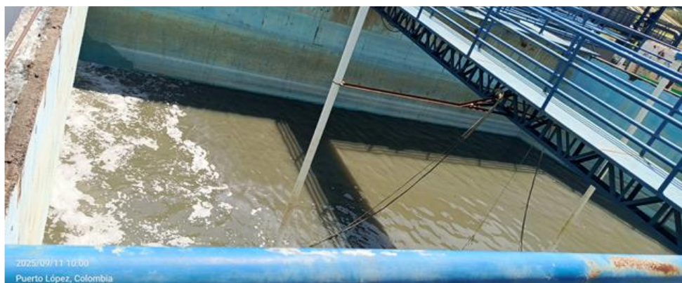
Imagen 40: Tanque de reactor biológico.
