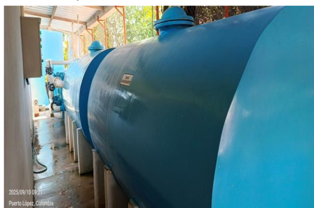
Tanques de cloración y almacenamiento
