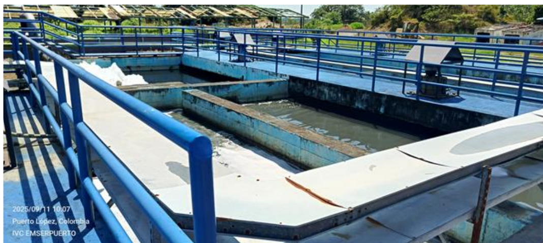
Imagen 39. Tanques de homogenización.
