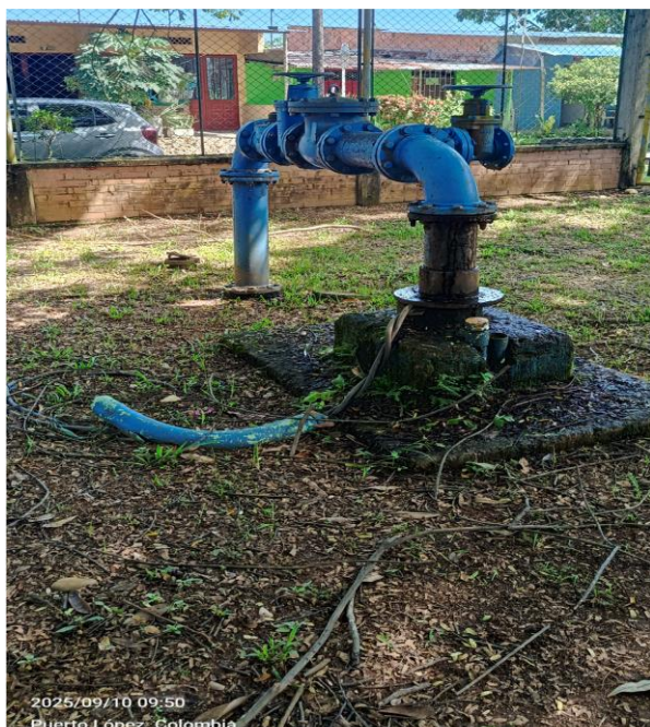
Tubería de salida agua cruda pozo
