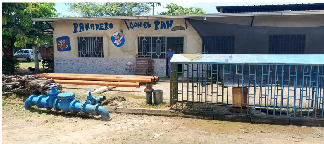
Tubería de salida agua cruda pozo
