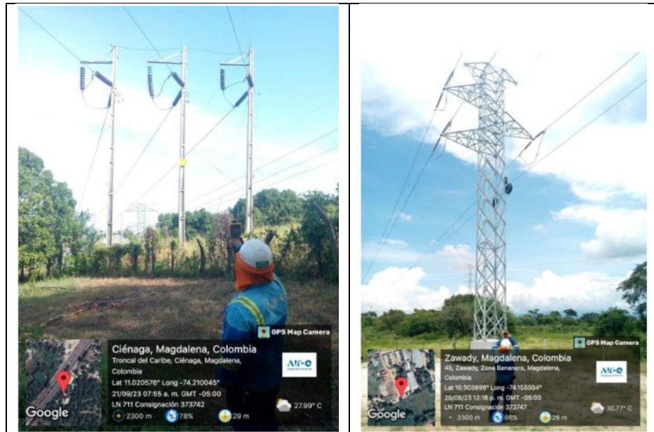
Fuente: AIR-E Informe Tercer Trimestre 2023
