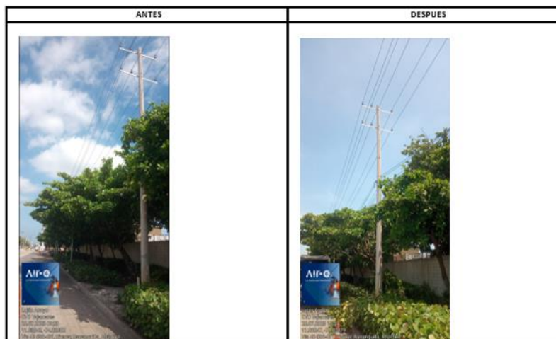
Fuente: AIR-E Informe Tercer Trimestre 2023
