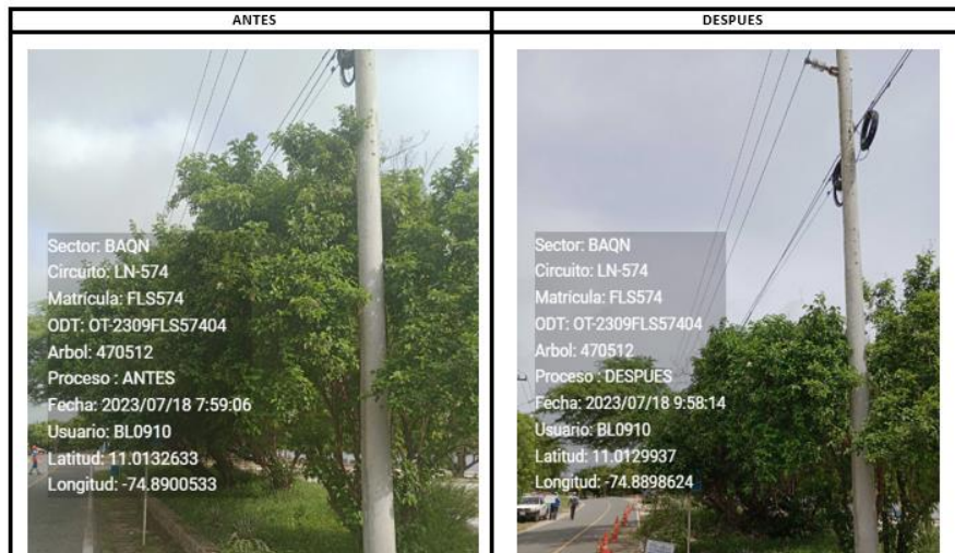
Fuente: AIR-E Informe Tercer Trimestre 2023
