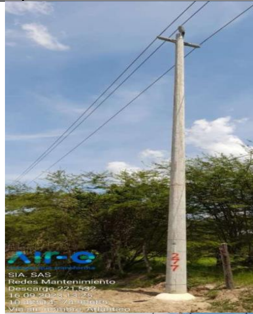
Reposición de conductor ACSR y AL – Circuito LN 5115
