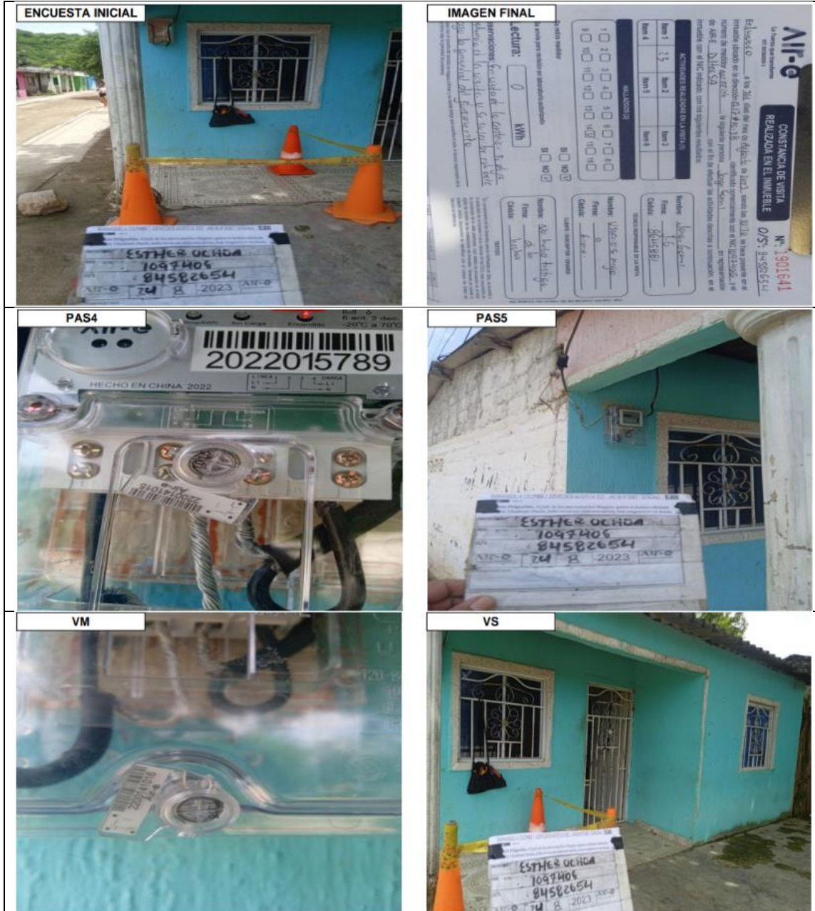
Fuente: AIR-E Informe Tercer Trimestre 2023
