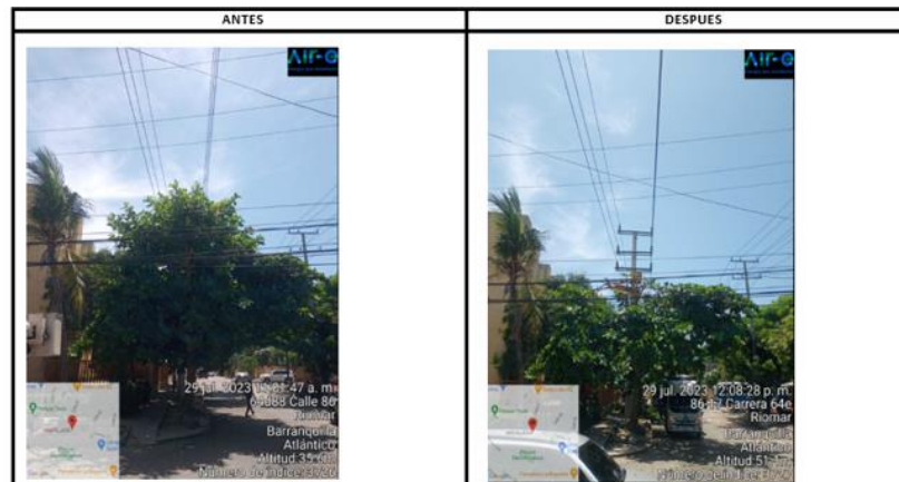
Fuente: AIR-E Informe Tercer Trimestre 2023
