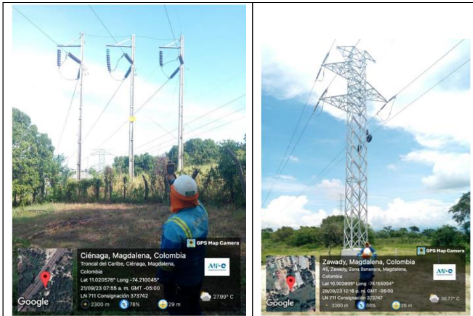
Fuente: AIR-E Informe Tercer Trimestre 2023
