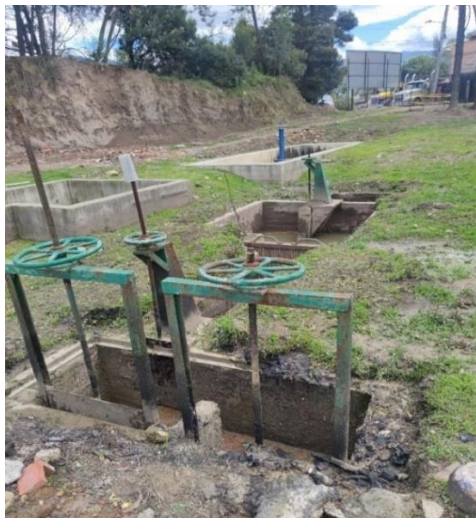
Imagen 17. Trampa de grasas – Rejillas de Cribado
