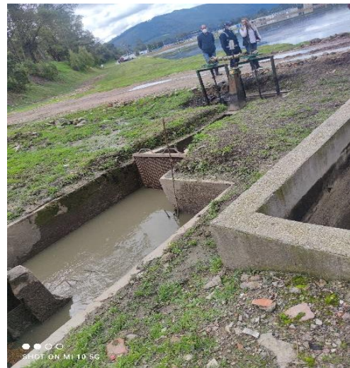
Imagen 17. Trampa de grasas – Rejillas de Cribado
