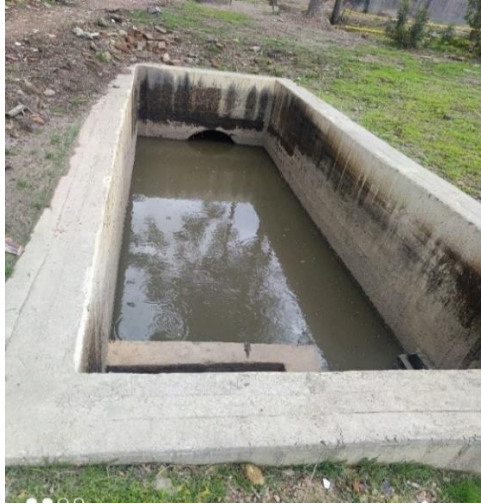
Imagen 17. Trampa de grasas – Rejillas de Cribado
