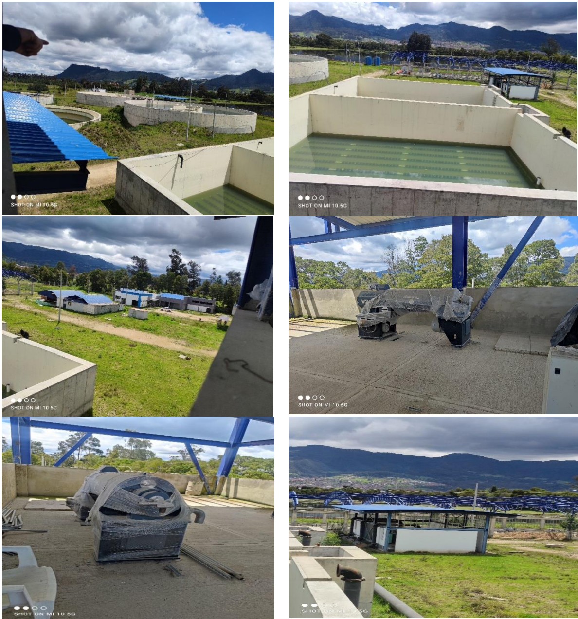
Imagen 20. Construcción PTAR Nueva
