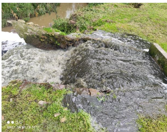
Imagen 19. Disposición final de las aguas residuales
