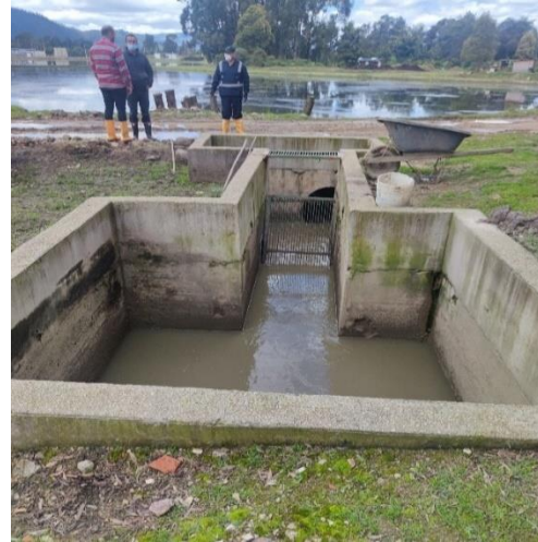
Imagen 15. Canal de transición o aliviadero Imagen 16. Canaleta Parshall
