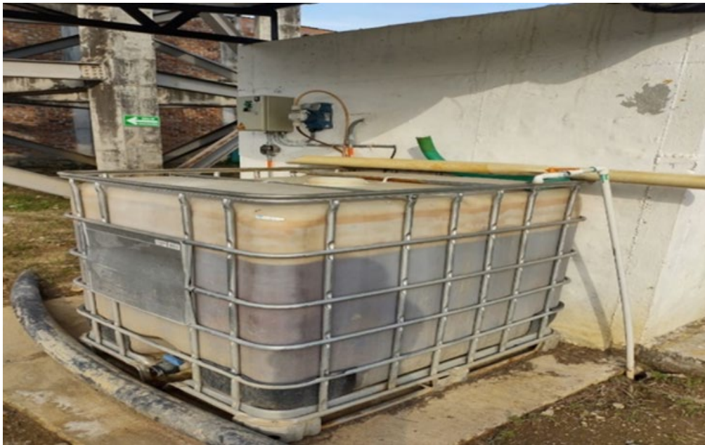
Imagen 9 Dosificador de coagulante PTAL Saldaña
