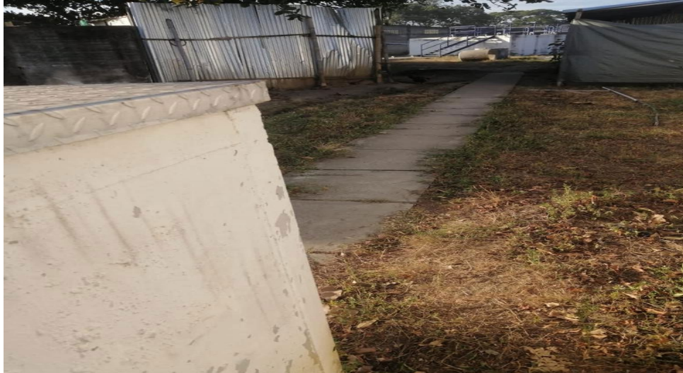
Imagen 3 Aducción Rio PTAP Saldaña
