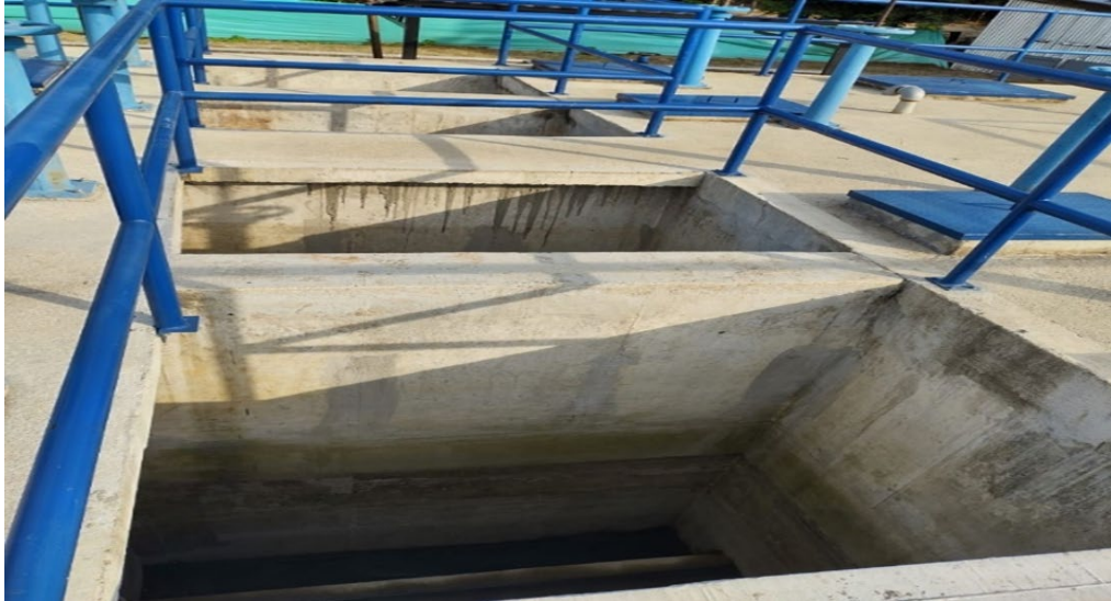
Imagen 8 Sedimentador PTAL Saldaña
