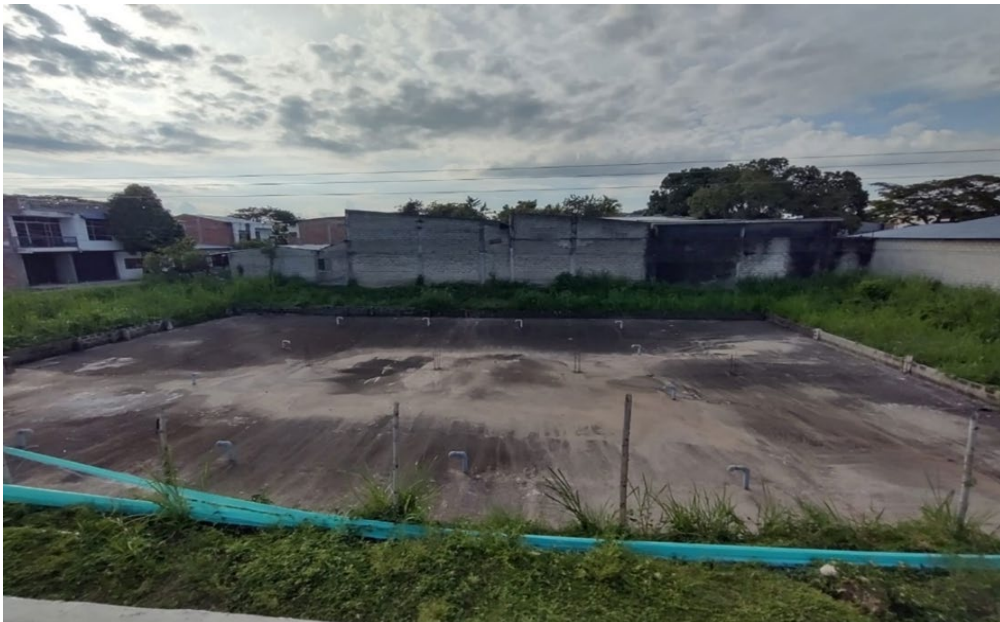
Imagen 11 Tanque de almacenamiento PTAL Saldaña
