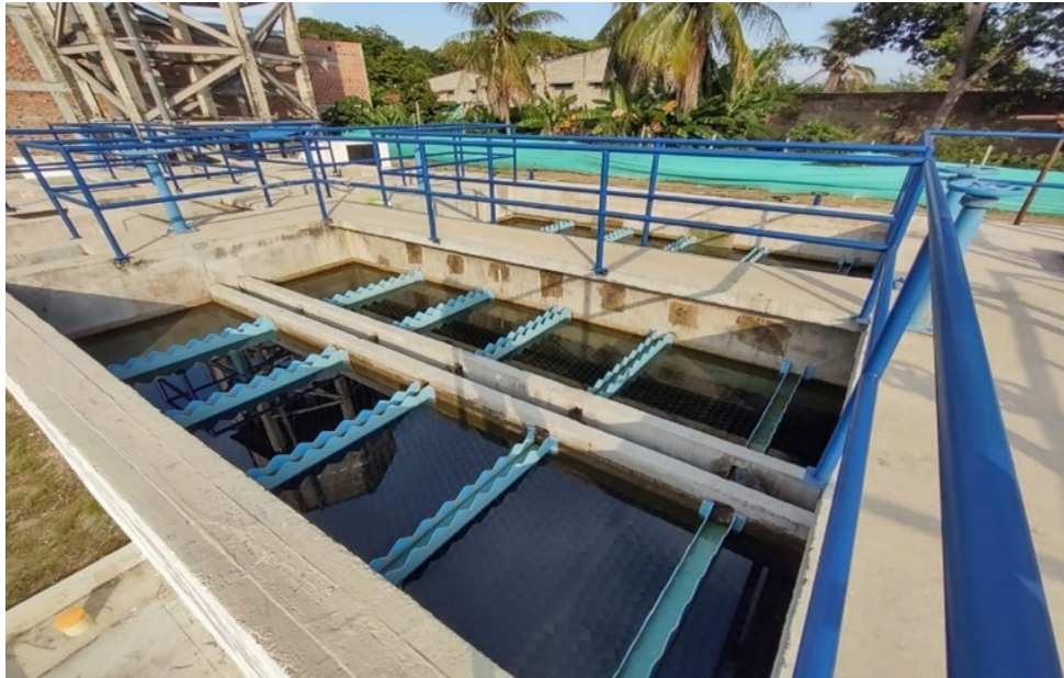
Imagen 7 Sedimentador PTAL Saldaña
