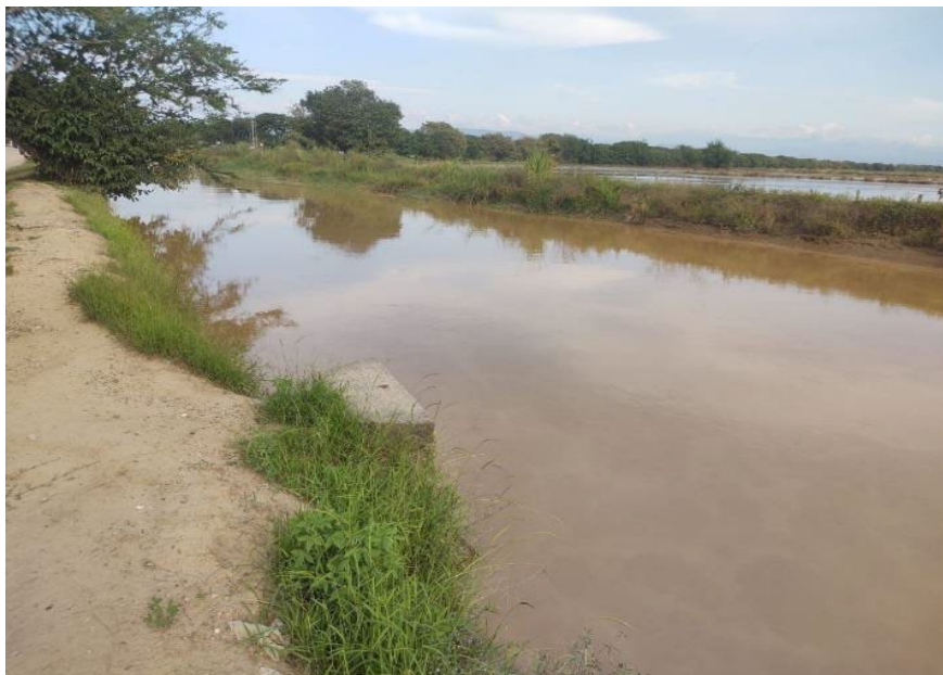
Imagen 1 Captación canal Ospina Pérez
