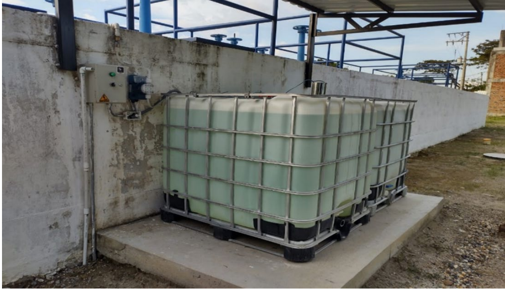
Imagen 10 Dosificador de Cloro PTAL Saldaña
