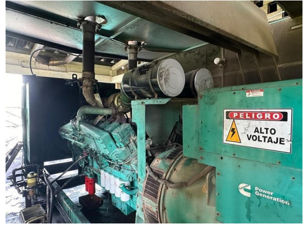
G4 – Cummins 1200 kW – 7309 horas - Fuera de servicio desde el 14 de enero de 2024.
