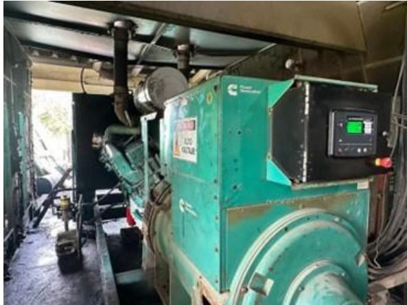
G4 – Cummins 1200 kW – 7309 horas - Fuera de servicio desde el 14 de enero de 2024.
