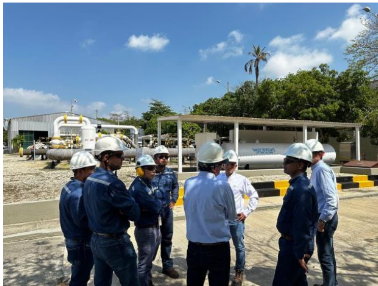
Fuente: Foto visita de SSPD a Estación Arenosa
