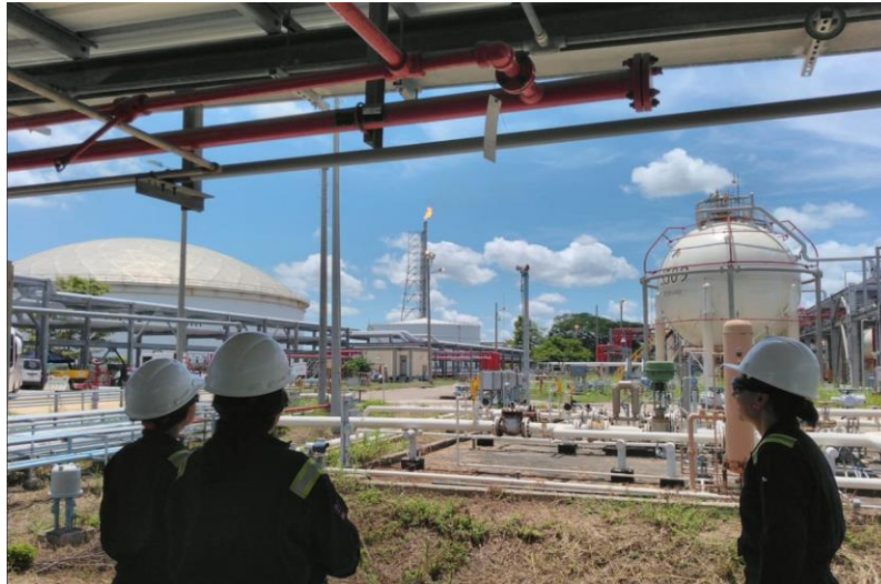
Figura 3 Tanques de almacenamiento de GLP
